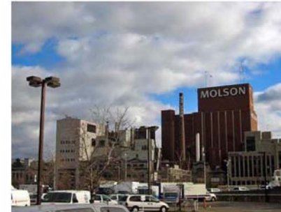
Le contexte - vue des bâtiments industriels de la brasserie Molson
