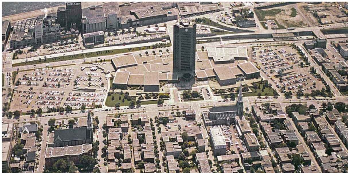
1970/73, la Maison de Radio-Canada, œuvre de l'architecte suédois Tore Björnstad
