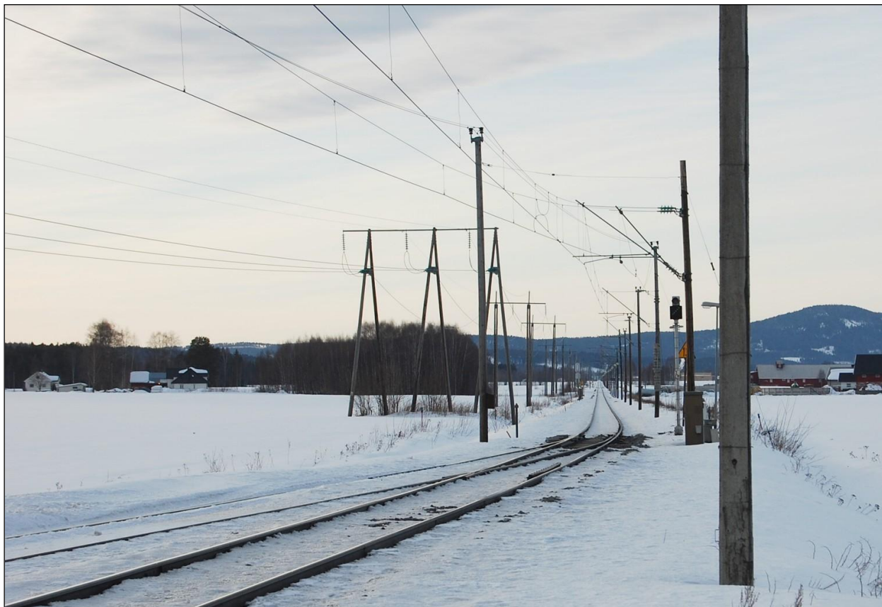
Bilde 1: Ved Sander, ca. 8 km sørøst for Skarnes, er Kongsvingerbanen rettlinjert 5 km mot vest, se bildet, og 4 km mot sørøst (bak opptaksstedet). Mellom disse rettlinjete avsnittene ligger imidlertid en krapp sving (i framgrunnen og utenfor venstre bildekant). Hvis svingen skal rettes ut for høye hastigheter, vil en måtte flytte banen flere hundre meter mot sør (til venstre). Det er det samme som å bygge nytt. Foto: © Norsk Bane AS.
