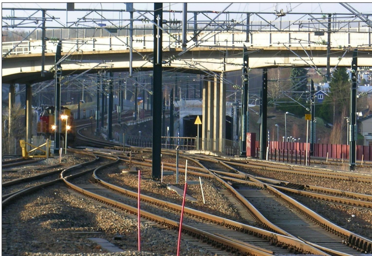
Bilde 2: Romeriksporten, her sett fra Lillestrøm, har to spor i samme løp, men ingen rømningsvei på den 7,2 km lange strekningen mellom Lørenskog og Bryn. Gjeldende forskrifter krever maksimalt 500 meter mellom rømningsveiene. I motsetning til mange nyere tunneler ligger skinnene i Romeriksporten heller ikke på en betongbane, men på sviller i pukk. Der er det ikke mulig å kjøre med vanlige utrykningskjøretøy (med gummihjul). Foto: © Norsk Bane AS.
