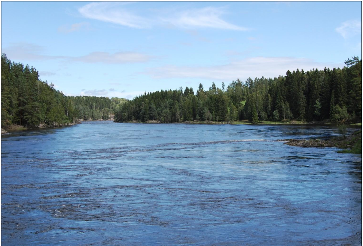
Bilde 21: Høyhastighetsbanen vil krysse Glomma på ei 215 meter lang bru, 26 meter over vannflaten. Sørøstre landkar vil stå i skogen midt på bildet. Lengst bak skimtes eksisterende jernbanebru. Foto: © Norsk Bane AS.
