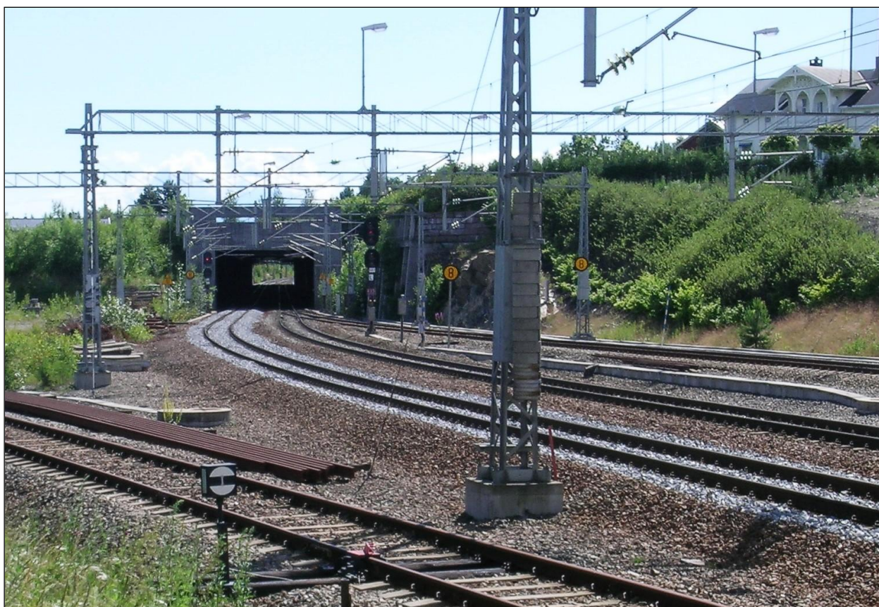
Bilde 3: Like sør for Ski stasjon har eksisterende bane mot Moss en sving for 80 km/t, se bildet. Svingen kan rettes ut til ca. 130 km/t når avgrensingen til sporet lengst borte er fjernet, men ikke til høy hastighet. Foto: © Norsk Bane AS.
