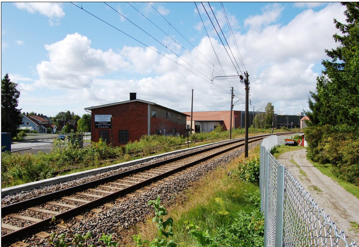
Bilde 22: En avgrensning fra høyhastighetsbanen til eksisterende stasjon på Askim og tilbake til høyhastighetsbanen vil åpne for en sentralt lokalisert stasjon uten større inngrep i bebyggelsen. Nåværende spor, som her ved Tornerud, vil bli fjernet og erstattet av et nytt dobbeltspor (med støyskjerming) på omtrent samme sted. Foto: © Norsk Bane AS.
