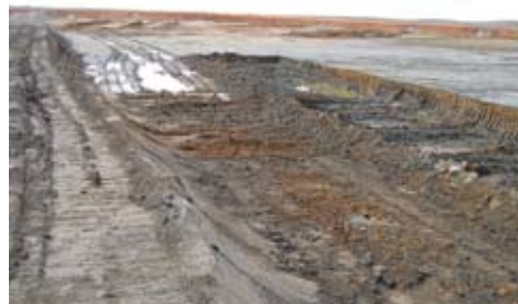
Konstruksi hulu menggunakan tailing
