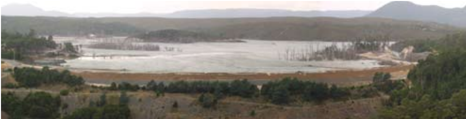
Dinding bendungan hilir fasilitas penyimpanan tailing pada keadaan iklim yang basah
