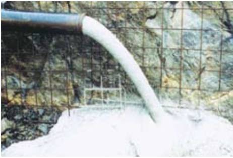
Pengukuran bawah tanah tailing pasta yang diberi semen
