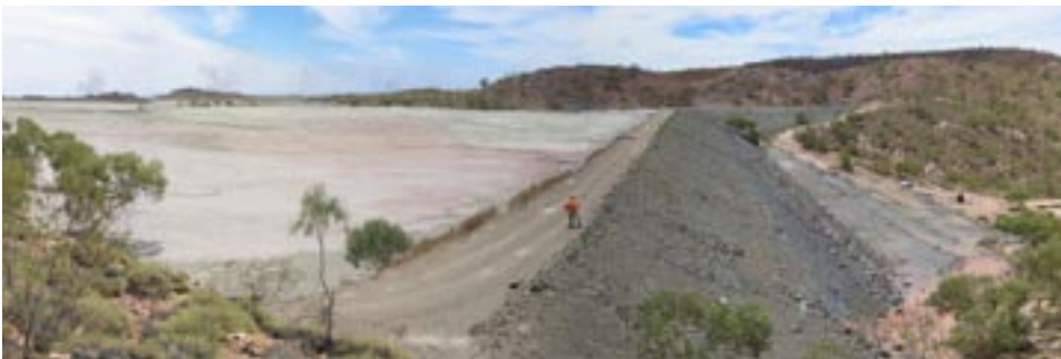
干燥气候背景中的尾矿贮存设施下游隔离墙
