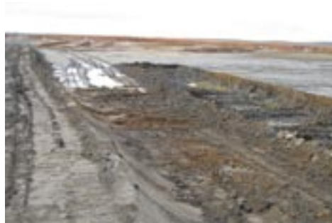
使用尾矿的上游施工
