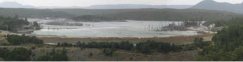
潮湿气候背景中的尾矿贮存设施下游隔离墙
