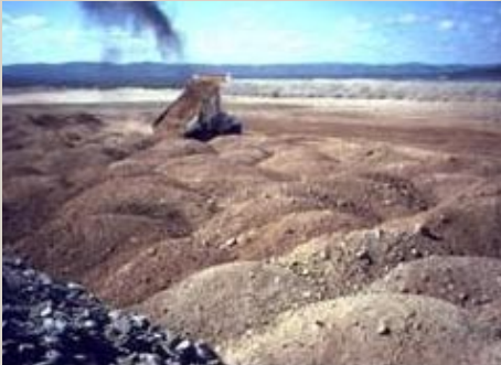
Colocación de mantillo pedregoso
