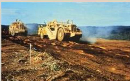
Desbastado del suelo
