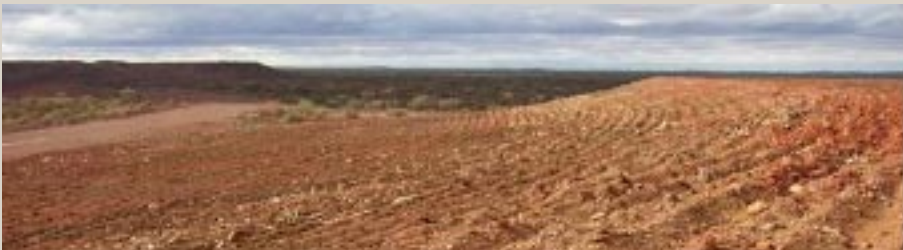
Ladera cóncava en Murrin Murrin Nickel Operation después de su construcción
