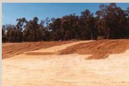
再次铺敷的表层土
