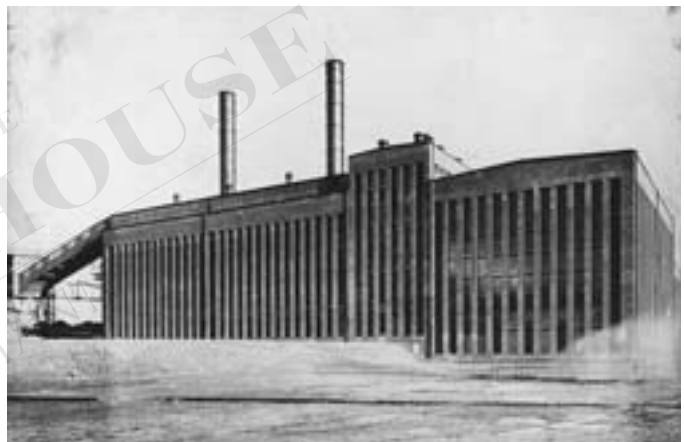
Hans Poelzig, Werner Issel. Kraftwerk Schulau, Unterelbe 1927/28
