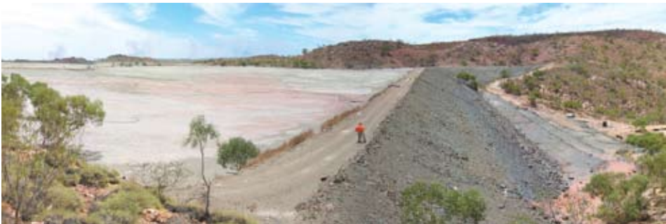
Tường ngăn ở hạ nguồn của cơ sở tồn trữ chất thải tại nơi có khí hậu khô
