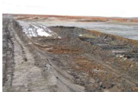
Phương pháp thải nâng cao đỉnh về phía hạ nguồn bằng chất thải
