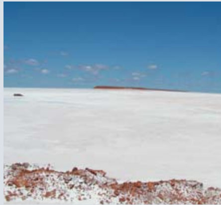
Hình ảnh dọc theo máng dốc từ đường chu vi của CTD TSF
