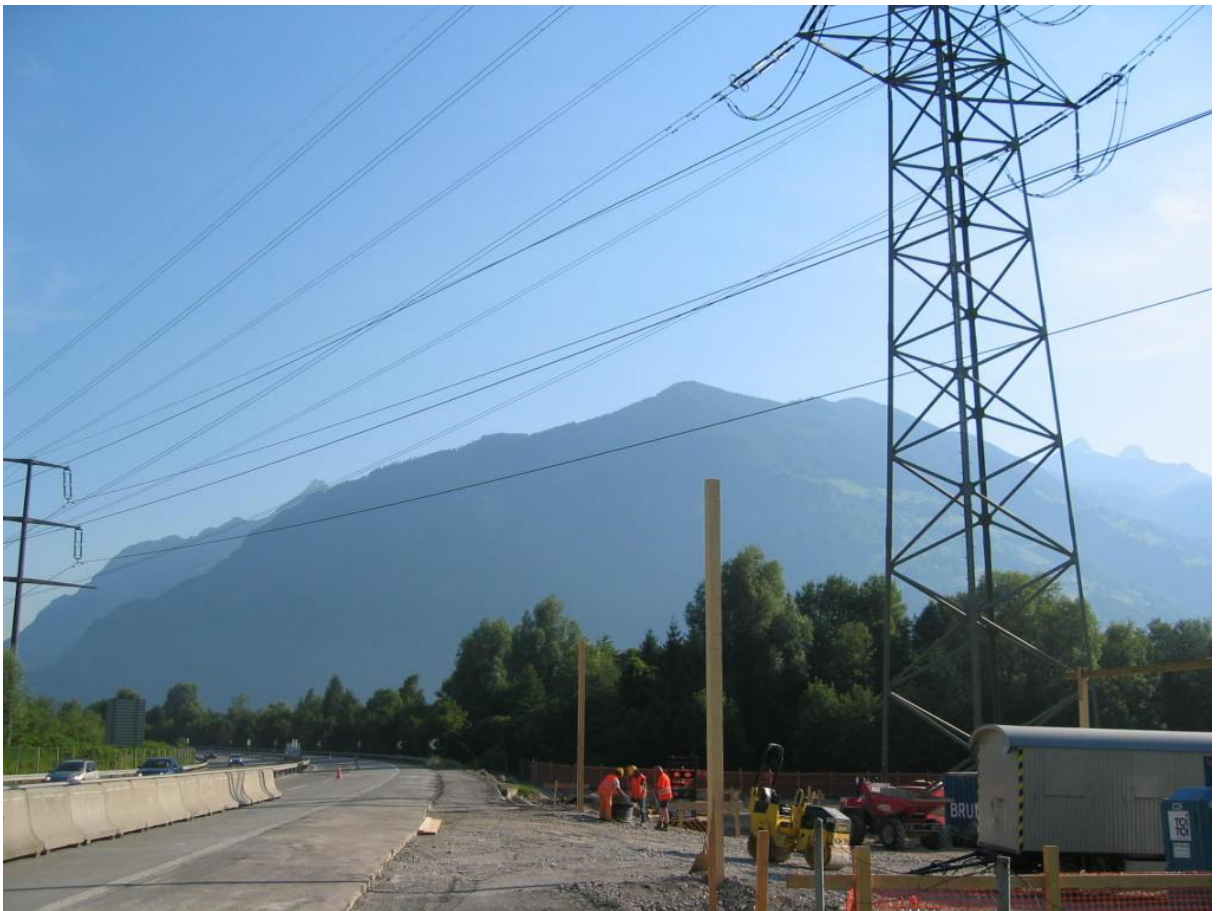
Abbildung 7: Baustelle unter der SBB-Leitung Amsteg/Wassen-Steinen
