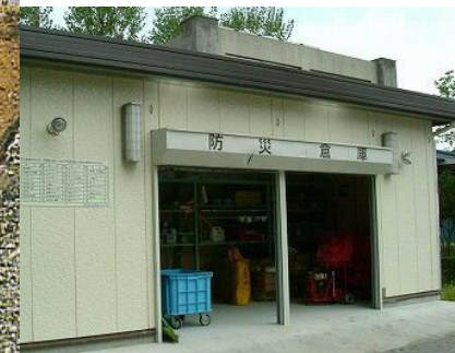
防災用備蓄倉庫
