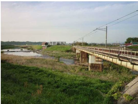
万願寺川と橋梁
