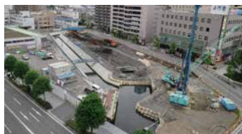
整備中の同事業エリア(2014年9月当時)
