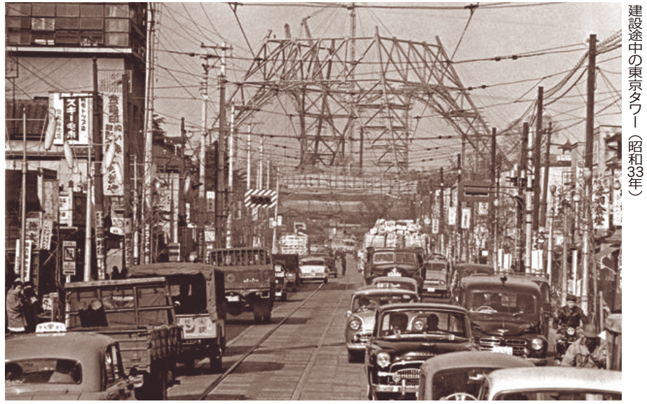
建設中の東京タワー（昭和33年）
