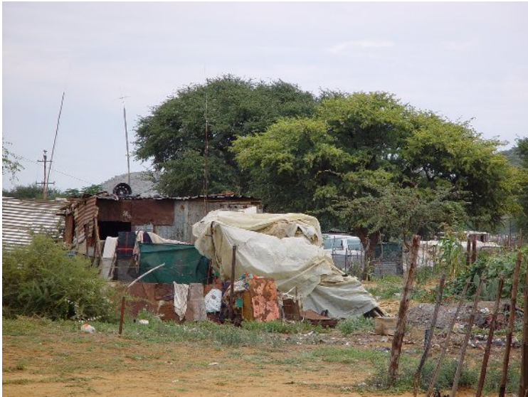
Photo 1: Plastikplanen und Wellblech waren die Hauptbaumaterialien in Otjivero (April 2007)
