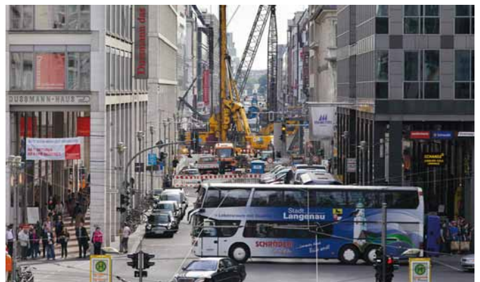
Stadtstaaten erhalten beim Finanzausgleich einen zusätzlichen Ausgleich, weil sie mit ihrer Infrastruktur auch Leistungen für das Umland erbringen: Baustelle in Berlin, Friedrichstraße.
