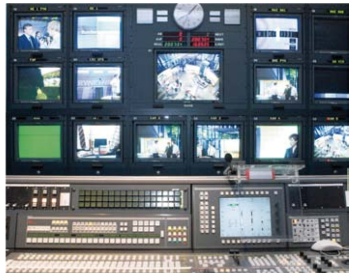
Regieraum des WDR in Köln: Hinter dem Tonmischpult befinden sich die Monitore mit Bildangeboten der Kameras und weiteren Zuspielmöglichkeiten.
