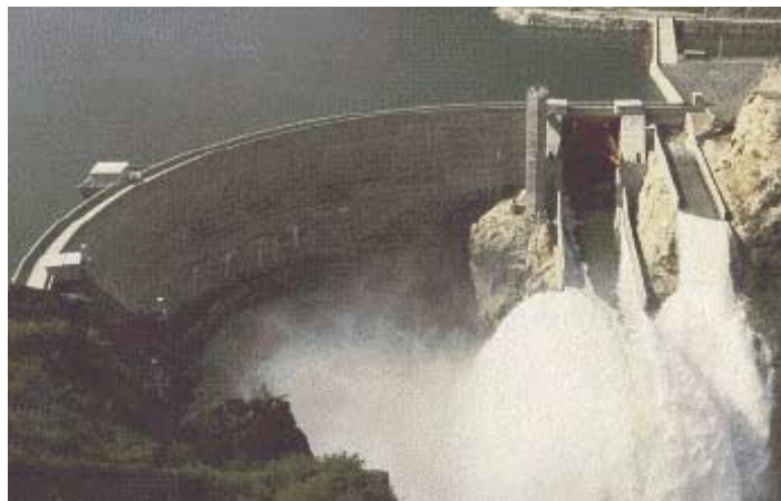
Bild 5.2: Beispiel einer Bogenstaumauer
