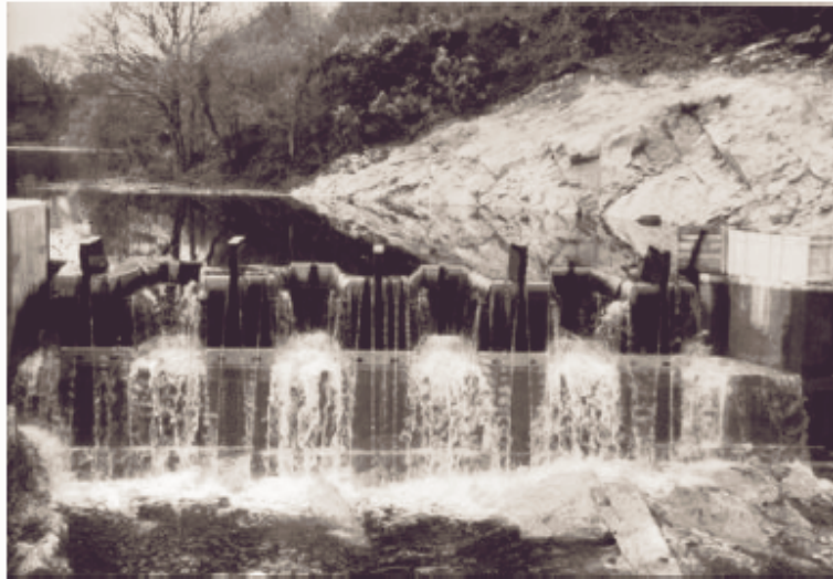
Bild 5.7: Sicherheitsverschluss von Hydroplus
