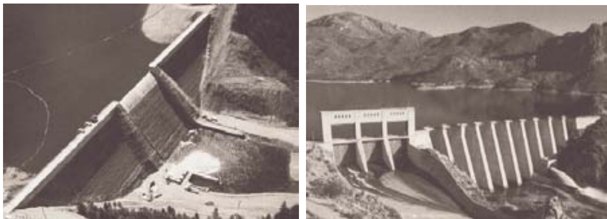
Bild 5.1: Beispiele von Gewichtsmauern (RCC) und Pfeilerkopfmauern
