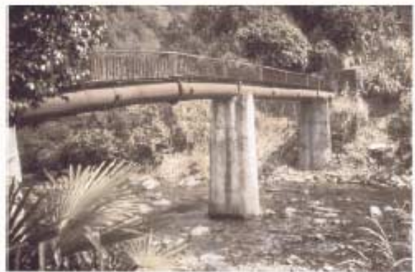
Bild 5.18: Rohrbrücke
