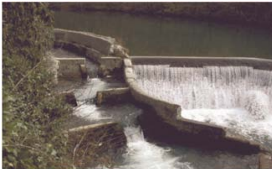
Bild 7.13: rustikaler Beckenpass
