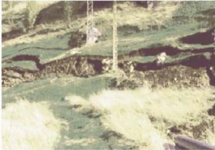
Bild 4.1: Überblick über die rechtsufrige Böschung
