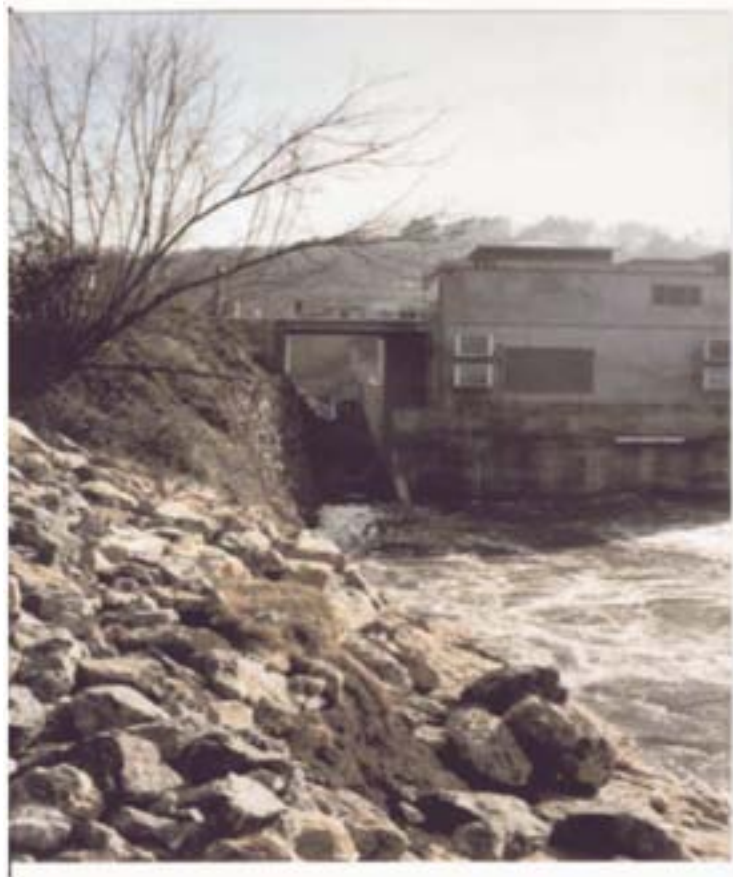
Bild 7.16: Kraftwerk, Fischpass links
