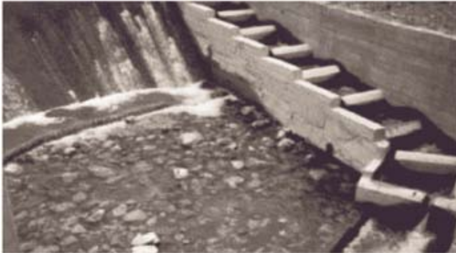
Bild 7.14: Fischpass mit vertikalen Schlitten
