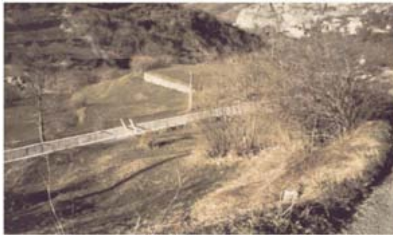
Bild 7.6: Konstruktions Phase – Betonkanal
