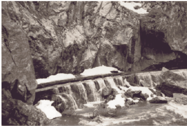
Bild 5.16: Seitlicher Überfall (Streichwehr)
