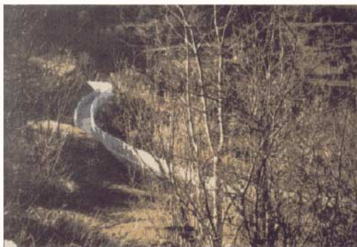
Bild 5.15: Kanal in der Cordinañes Anlage
