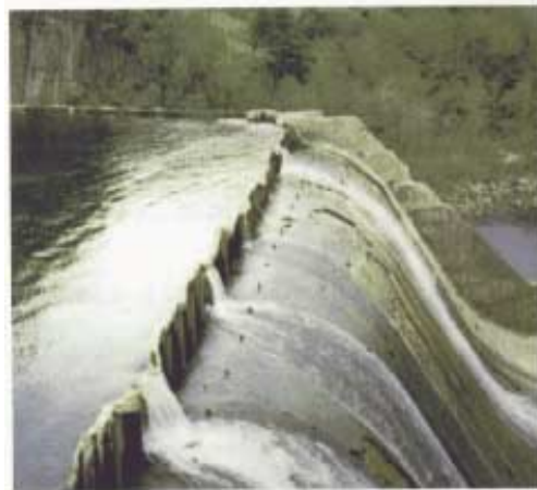
Abbildung 5.10: gelenkig gelagerte eingesetzte Dammbalken
