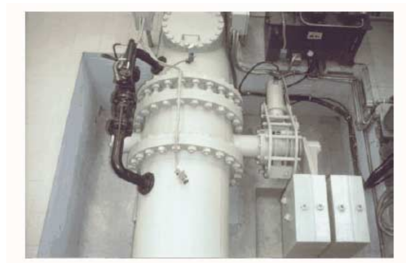
Bild 5.14: Hydraulisch bedienbare Drosselklappe
