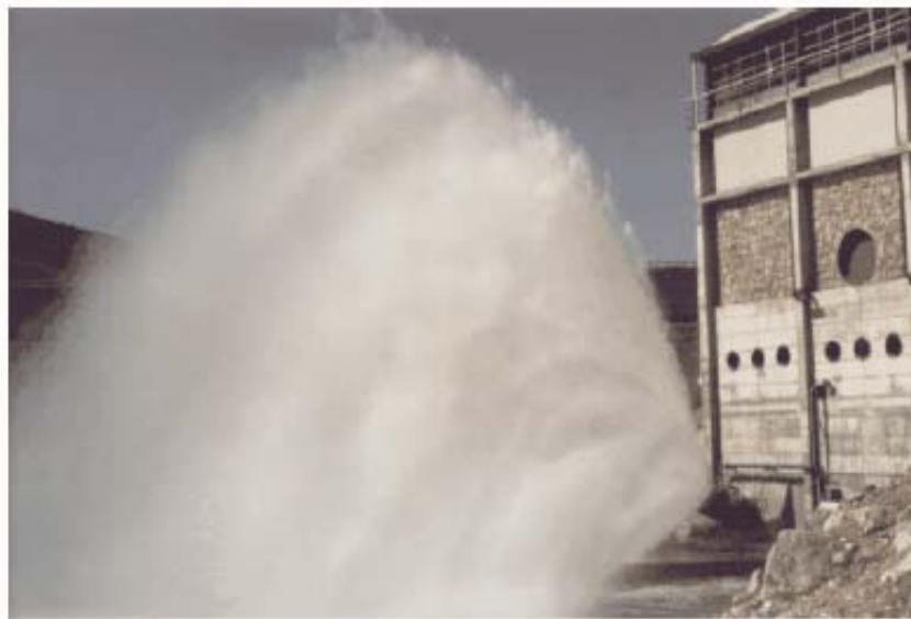
Bild 5.19: Freie Strahlentlastung durch bypass
