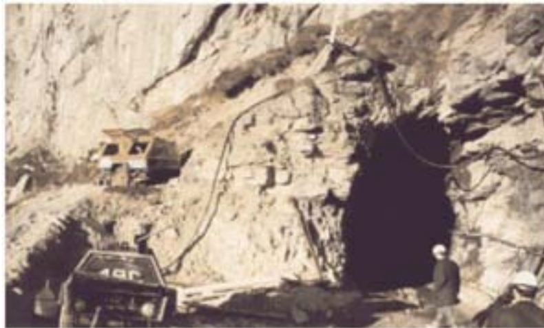
Bild 7.8: Stolleneingang während der Konstruktionsphase
