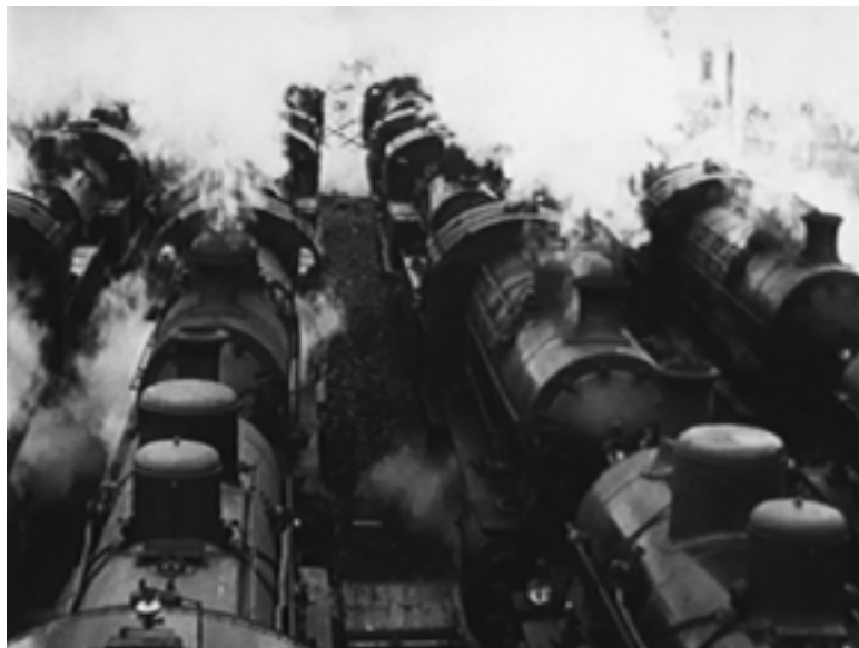
Video-Still aus: SFWs 4720.6.1941. Berner Eisenbahnbrücke
