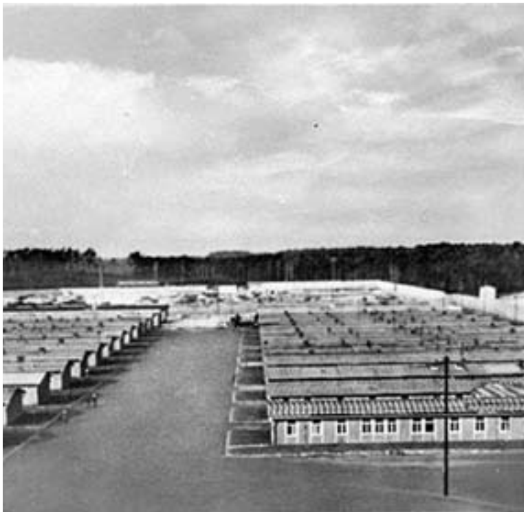
Baracken Frauenlager Ravensbrück
