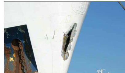
Beschädigung beim MV NOTOS (Vorsteven)
