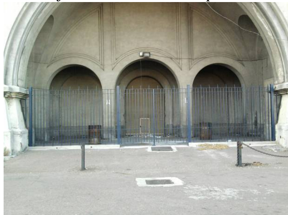
Reja sobre acceso norte derecho.
