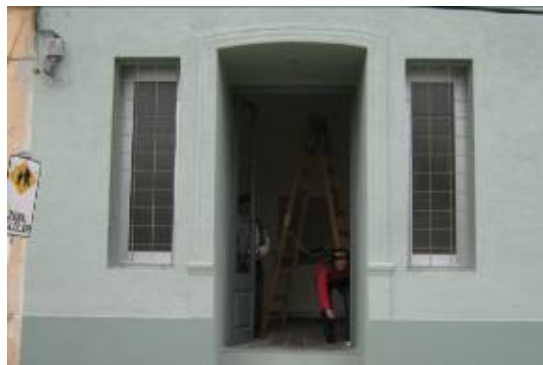
Acceso vivienda del administrador por 25 de agosto
