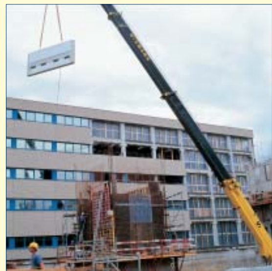
Mobile Fassadenplatten, Neubau VA
