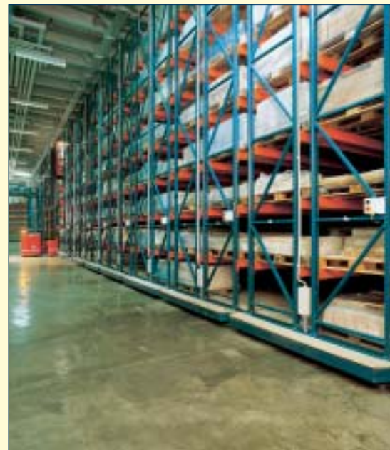
Hochregallager mit Verschieberegalen im Untergeschoss in Stuttgart
