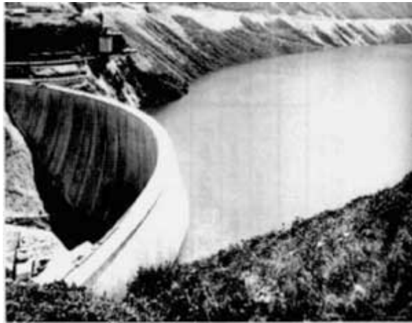
Barrage de Nalps (Photo H. Rostetter, Ilanz)
