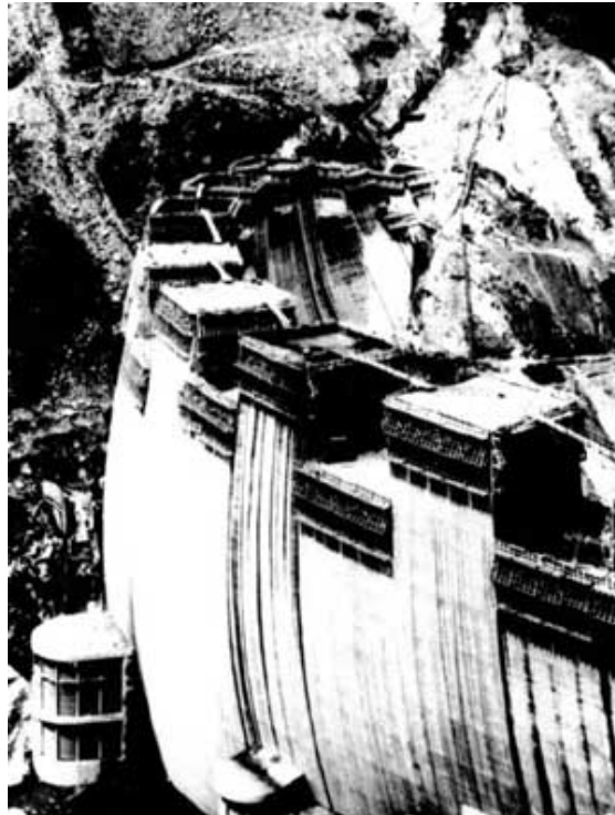
Barrage de Nalps pendant la construction
