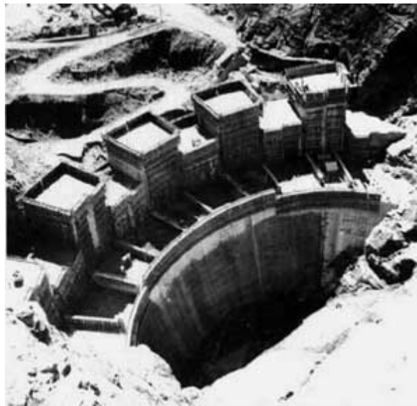
Barrage de Mauvoisin en construction
