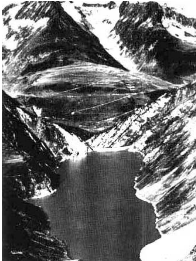
Barrage de Curnera (Photo Comet, Zurich)
