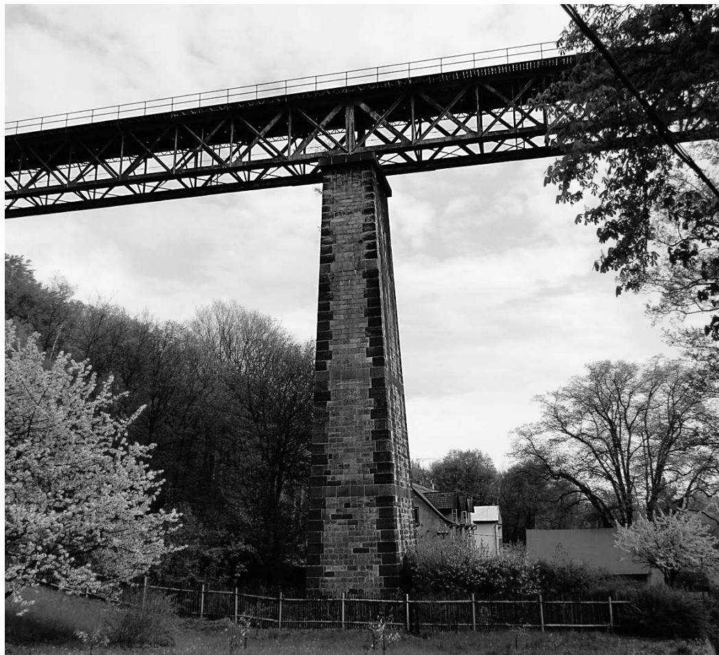
Pilíř viaduktu, 2008, foto Jiří Sedláček.
