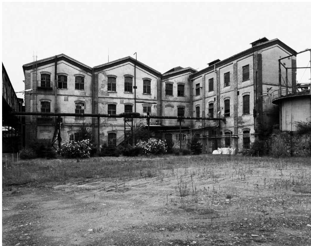
Původní budovy v západní části areálu, 2008, foto Benjamin Fragner.
