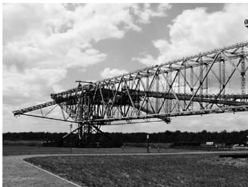
01 Skryvkový most F60 v Lichterfeldu u Finsterwalde, 2007, foto Gunnar Ries.
