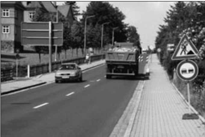
„Baustelle“ auf der Waldheimer Straße Ende Juni 2006
