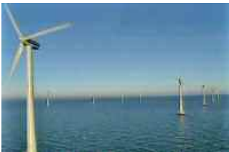
Erneuerbare Energien wie die Windkraft sind eine Alternative zum Kohlestrom
