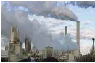
Allein die Braunkohlenkraftwerke in NRW stoßen jedes Jahr rund 100 Millionen Tonnen CO 2 aus
