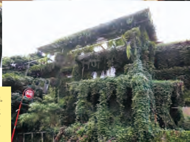
築約40年のみどり荘。自然エネルギーの導入と「電力見える化」のプロジェクトが進められている
