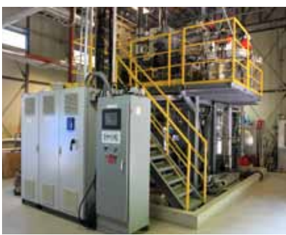
アンモニアガスでタービンを回して発電する仕組み(松之山温泉バイナリー発電所)
