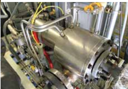
アンモニアガスでタービンを回して発電する仕組み(松之山温泉バイナリー発電所)
