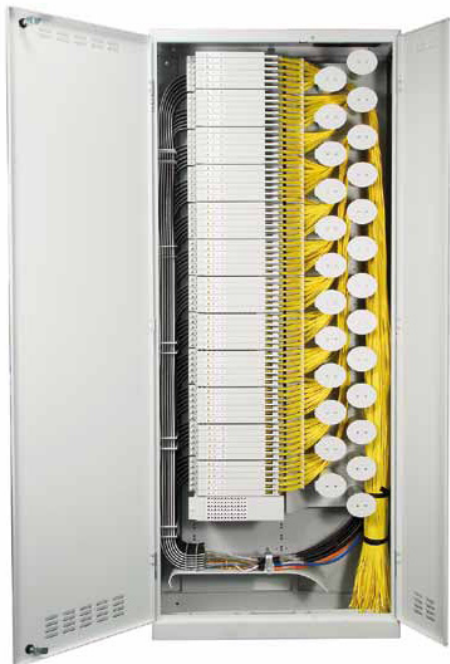
Verteiler Kabelschrank
