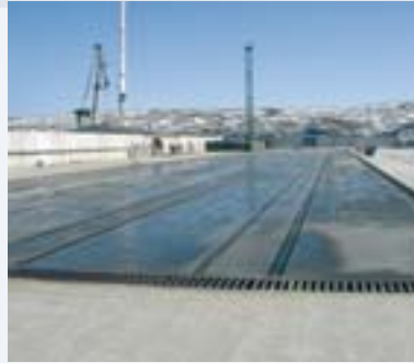
Fertiggestellte Lagerplatte mit Schienensystem im April 2006
