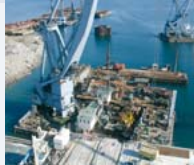
Fertigstellung des Dockanlegers im Juni 2006
