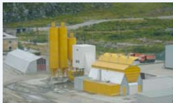
Betonwerk auf der Baustelle in der Sajda-Bucht
