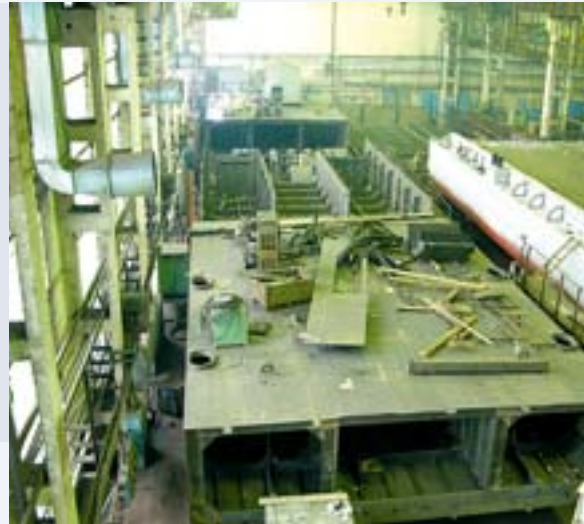
Bau von Schwimmbehältern für flüssige radioaktive Abfälle, Schiffshebe-pontons für Atom-U-Boot-Sektionen und Pontons zur Pierverlängerung
