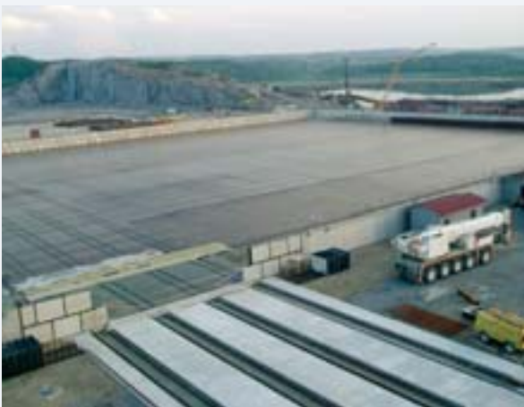
Erster Bauabschnitt des Langzeitlagers in der Sajda-Bucht im Juli 2006
