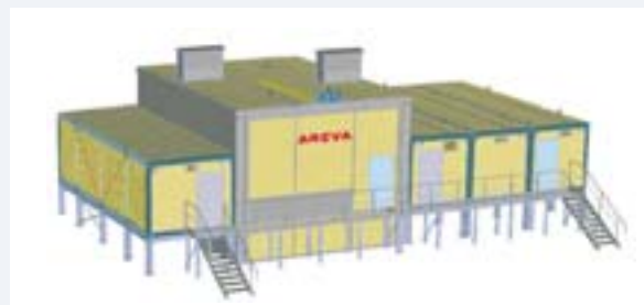
Neue Umspannstation 35kV/6kV für die Sajda-Bucht
