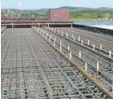
Einbau von Bewehrung und Beginn der Betonierarbeiten für die Lagerplatte im Juli 2005
