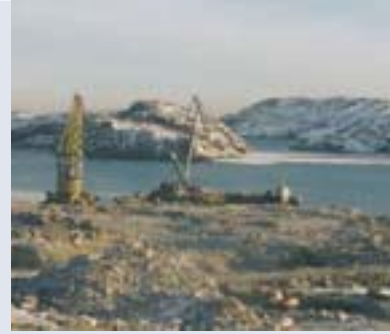
Baugrundvorbereitung und Herstellung des Planums bis Mai 2005 fertiggestellt
