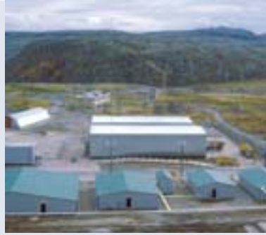
Fertigstellung der Baustelleneinrichtung im September 2004
