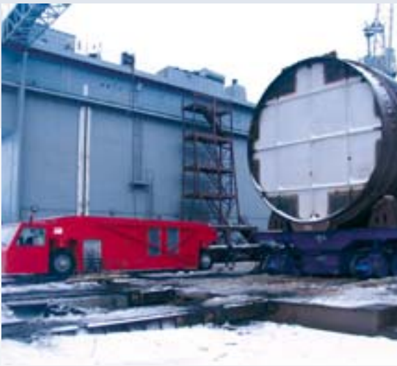
Powerstation und Reaktorsection auf Kielblockträgern
