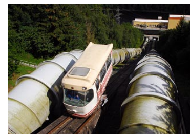
Zwischen den Rohrleitungen führt eine Standseilbahn zum idyllischen Panoramablick.
