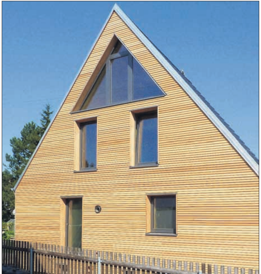
Mit einer Holzfassade erstrahlt das alte Haus neu und modern. Dahinter lässt sich gute eine zeitgemäße Wärmedämmung verstecken.
