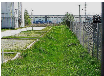
Abb. 17: Niederschlagswasserversickerung in einer Mulde
