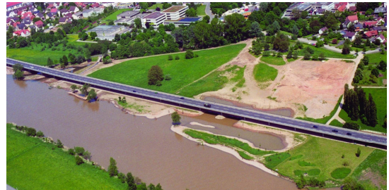
Abb. 16: Renaturierung der Elzmündung bei Mosbach/Neckar
