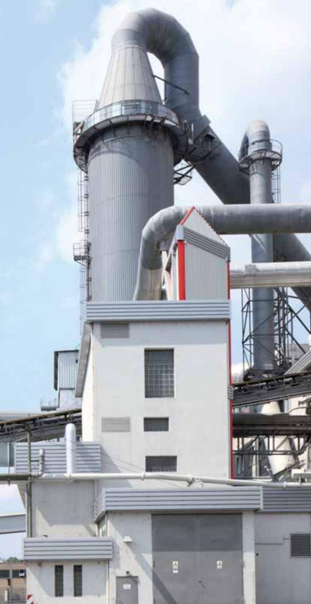
Verdampfungskühler zur Konditionierung der Ofenabgase
