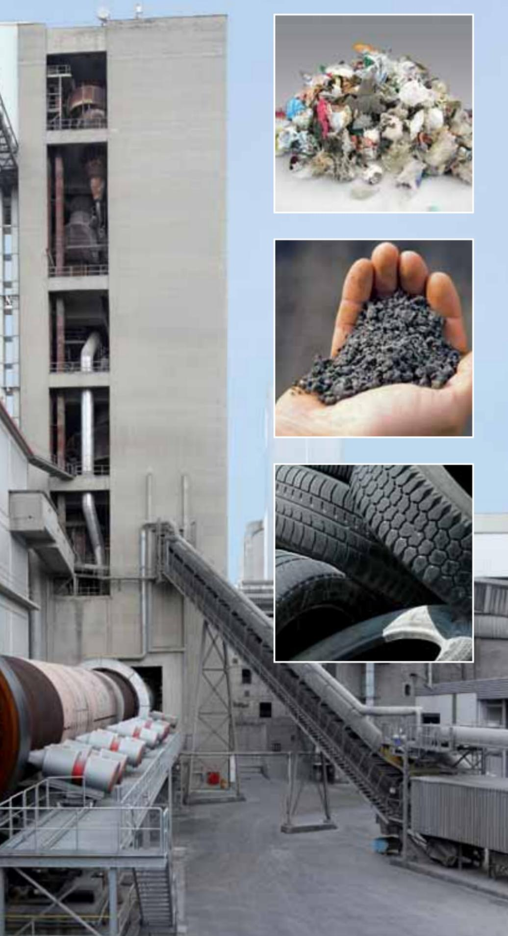
Die Verwendung von aufbereiteten Reststoffen wie Kunststoff- oder Verpackungsmaterial sowie Klärschlamm und Altreifen ermöglicht es, fast vollständig auf Kohle und Öl zu verzichten.
