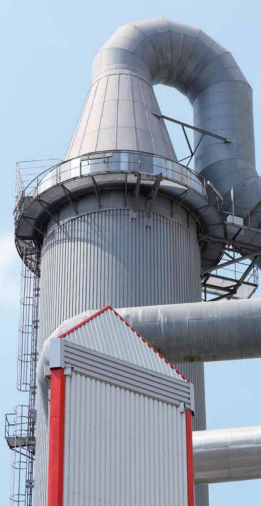
Komplexe Filteranlagen mit vorgeschaltetem Verdampfungskühler vermeiden Staubimmissionen
