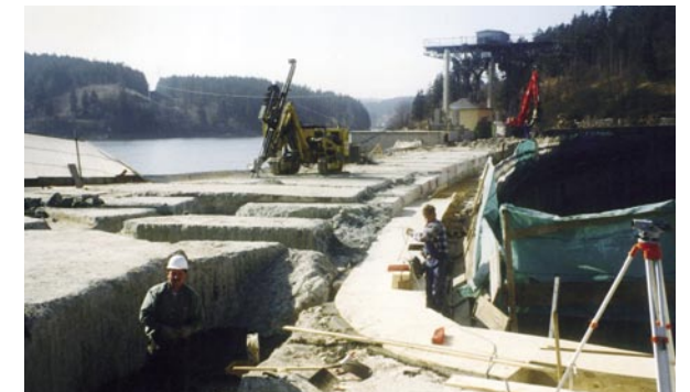
Sanierung der Staumauerkrone 1999
