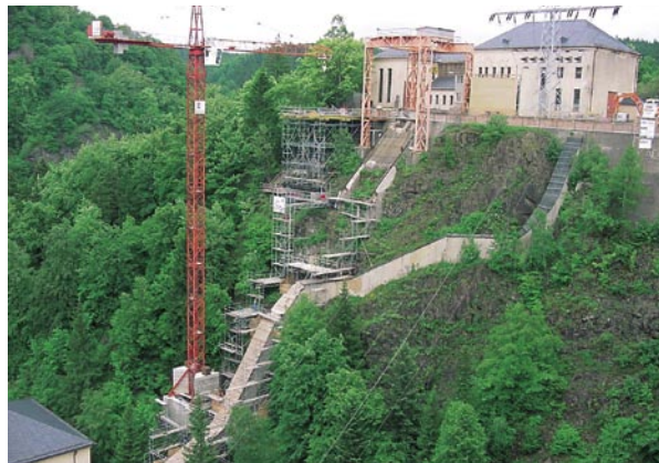
Ertüchtigung der Standseilbahn 2002
