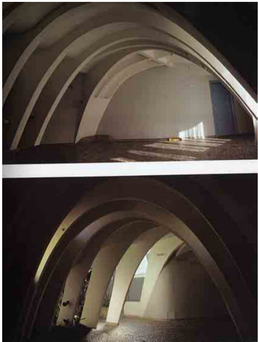
Abb. 23: Casa Milá · Dachkonstruktion
