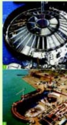
1. Construction de la première embase de la cale sèche sur le site de l'ouvrage existant. Construction de la deuxième embase en parallèle.
