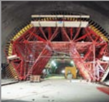
AS der Fahrleitungsbahn 3-er Teilung (x190m) Innenschale
