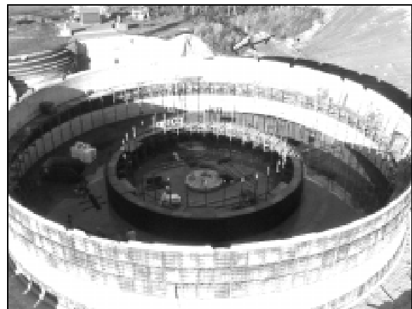
Abb. 3-33: Bau eines Betonfermenters
