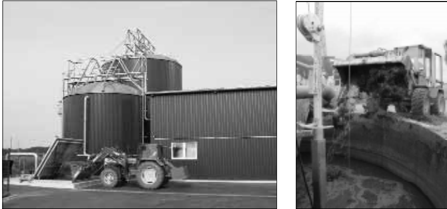
Abb. 3-24: Vor- bzw. Annahmegrube bei der Beschickung; Fotos: Loick Bioenergie, ENR - Energiegesellschaft nachwachsender Rohstoffe mbH; Hugo Vogelsang Maschinenbau GmbH
