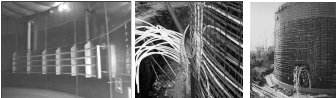
Abb. 3-35: Edelstahlheizrohre im Fermenter verlegt (links); Einbau von Heizschläuchen in die Fermenterwand (Mitte und rechts); Fotos links und Mitte: Biogas Nord GmbH; Foto rechts: PlanET Energietechnik
