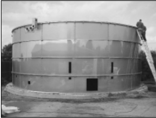
Abb. 3-34: Im Bau befindliche Edelstahlfermenter; Foto: Anlagen- und Apparatebau Lütke GmbH
