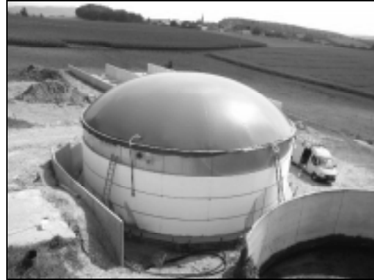
Abb. 3-34: Im Bau befindliche Edelstahlfermenter; Foto: Anlagen- und Apparatebau Lütke GmbH
