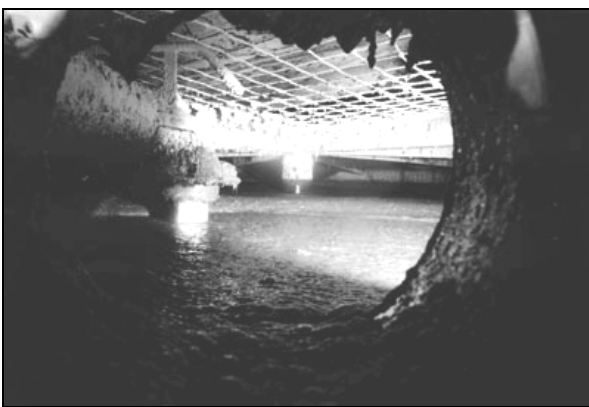
Abb. 3-30: Blick in einen Fermenter; Foto: Biogas Nord GmbH
