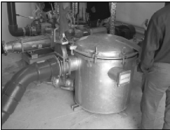
Abb. 3-29: Schwerstoffabscheider in einer Rohrleitung; Foto: Institut für Energetik und Umwelt gGmbH
