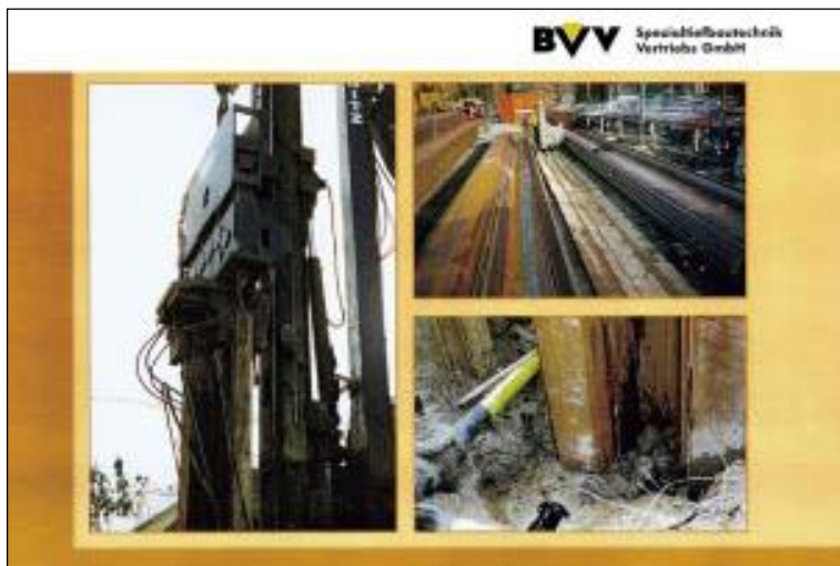
Bild 8 und 9: Rüttelspülverfahren
