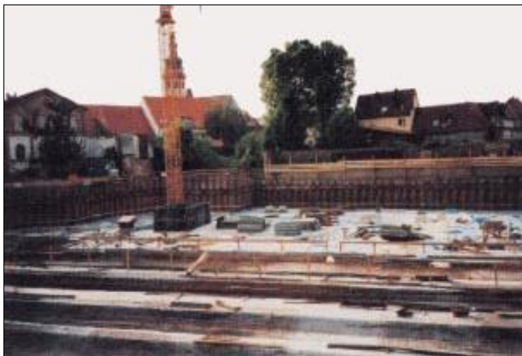
Foto: Baustelle „Weiherhof-Center“, Karlsruhe-Durlach
