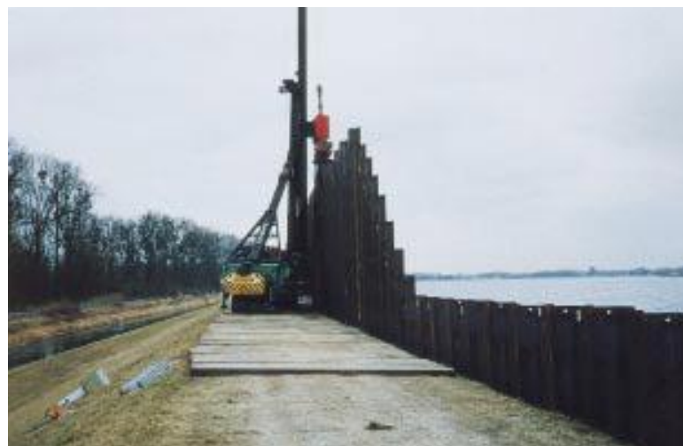
Spundwandrammung (2. Stufe – Pilgerschritte)
