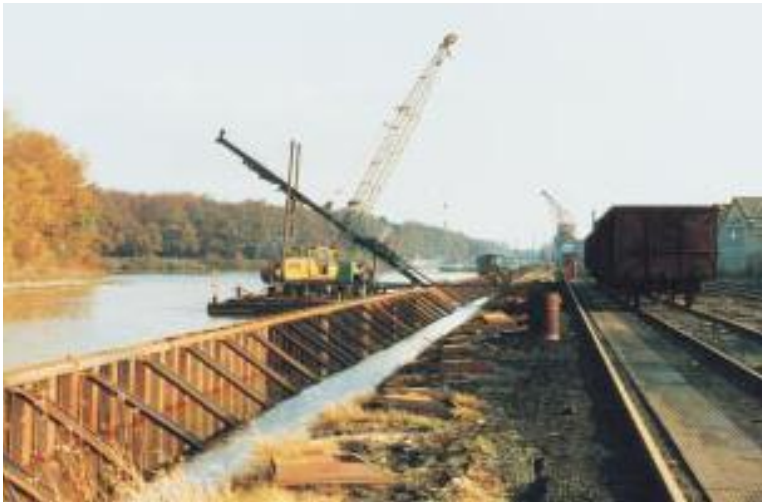
Bild 6: Spundwandufer; Verankerung mit Schrägpfählen
