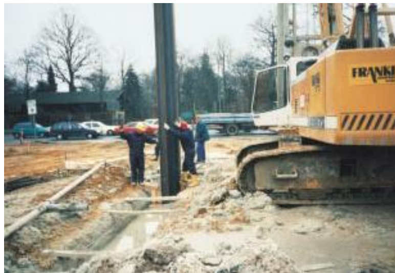
Bild 3: Einstellen der Spundbohlen in die flüssige Dichtwandmasse
