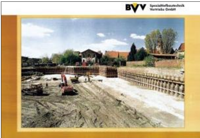
Bild 12 und 13: Fertige Baugrube
