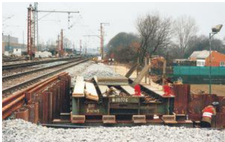
Bild 8: Auf Stahlspondwänden gelagerte DB-Hilfsbrücke
