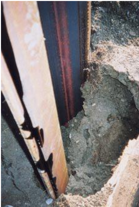
Sackungen bei Vibration durch lockere Schichten
