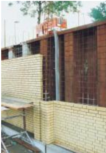
Bild 9: Mit Klinkern verkleidete gespundete Stützwand
