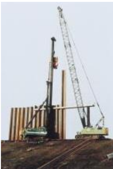
Proberammung mit Hochfrequenz-Vibrator und doppelter Rammführung
