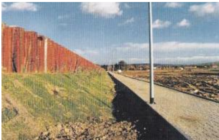
Abb. 4 Sanierungsbauwerk mit bepflanzter Bodenanschlüttung (Blick entlang der südlichen Längsseite, Länge 300 m)
