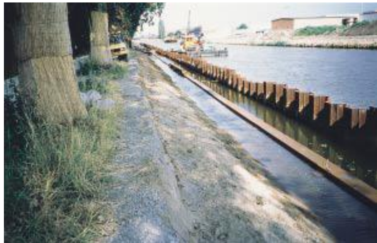
Bild 16: Behelfsspundwand zur Verholmung und Verankerung einer KRT-Wand
