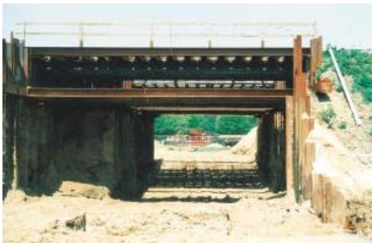
Bild 9: Spundwandkasten Widerlager West (Teilaushub)
