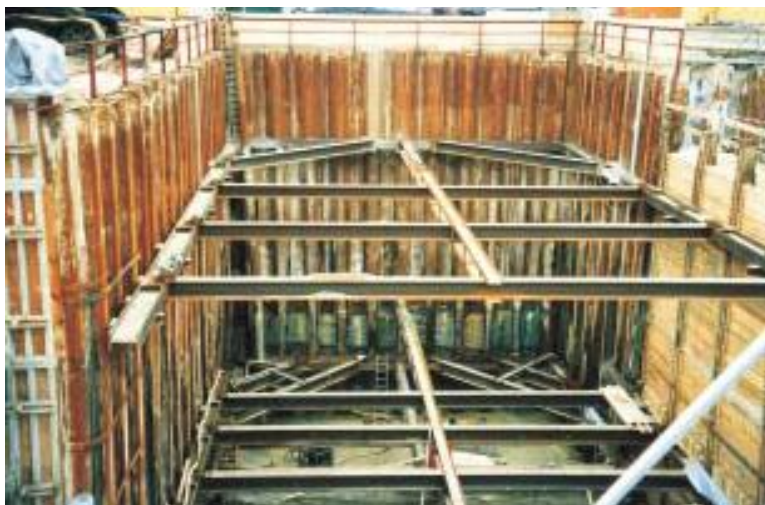
Bild 7: Baugrube für das Pumpwerk
