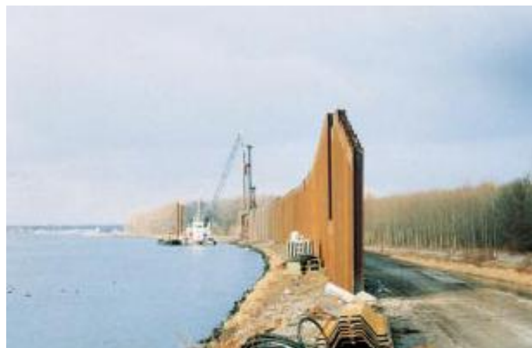
Spundwandrammung (1. Stufe)
