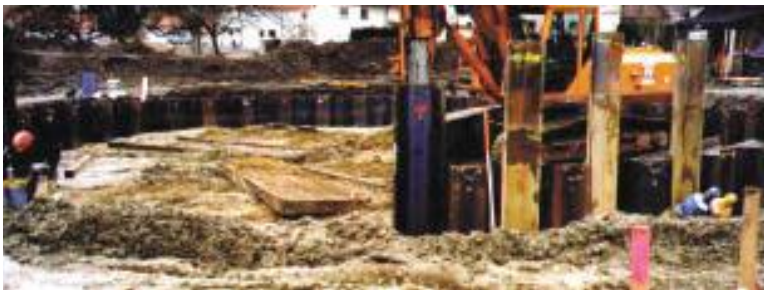
Bild 6: RÜB Oberuhldingen, beim Einbauen der Spundwände
