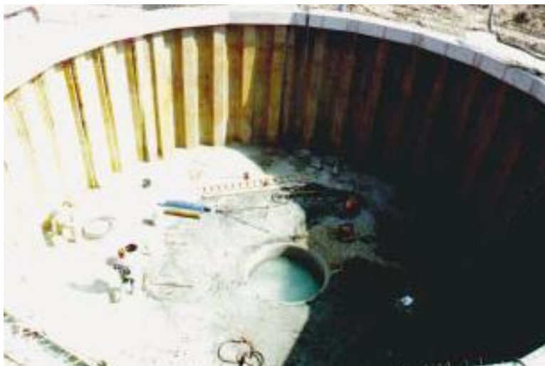
Bild 7: RÜB Oberuhldingen nach Einbau des Unterbetons
