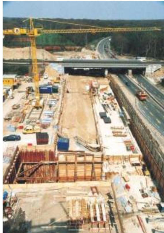
Bild 1b: nördlicher Bereich mit bereits fertiggestellter Bahnbrücke
