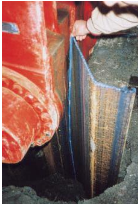
Sackungen bei Vibrationen durch lockere Schichten
