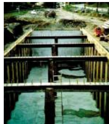
Bild 2: RKB Askaniaweg in Überlingen vor dem Herstellen der Bauwerksdecke
