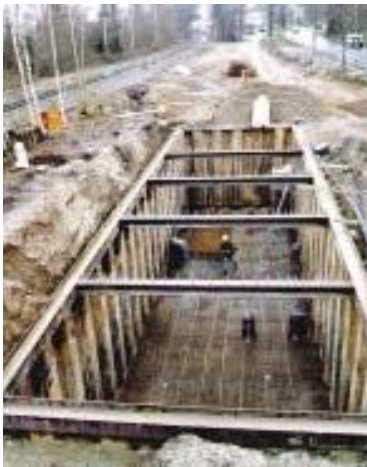
Bild 1: RKB Askaniaweg in Überlingen beim Herstellen der Bodenplatte
