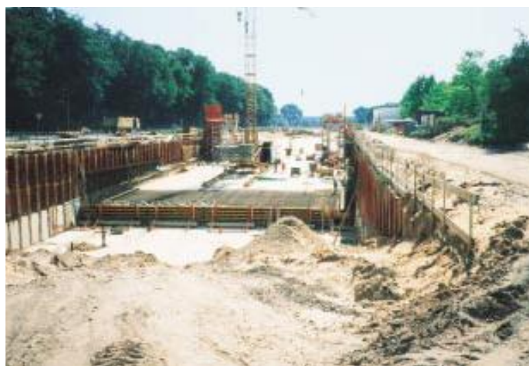
Bild 4: Wasserdichte Baugrube mit teilweise betonierter Trogsohle
