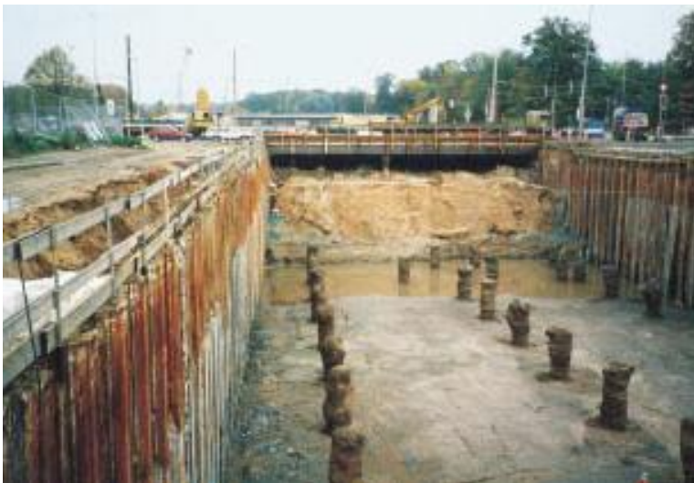
Bild 6: Ansicht der Hilfsbrücke
