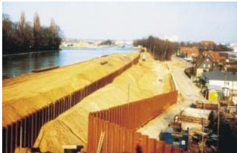
Bild 7: Spundwand als Fangedamm und zum Abfangen einer Böschung
