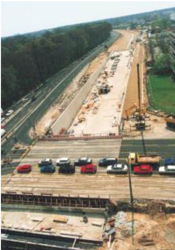
Bild 1a: südlicher Trogbereich
