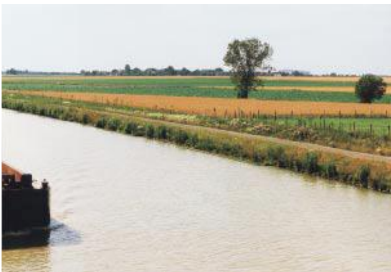
Bild 12 bis 14: Spundwand mit abgesenkter Oberkante
