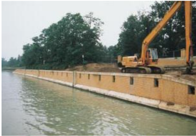
Bild 10: Mit Klinkern verkleidete gespundete Uferwand
