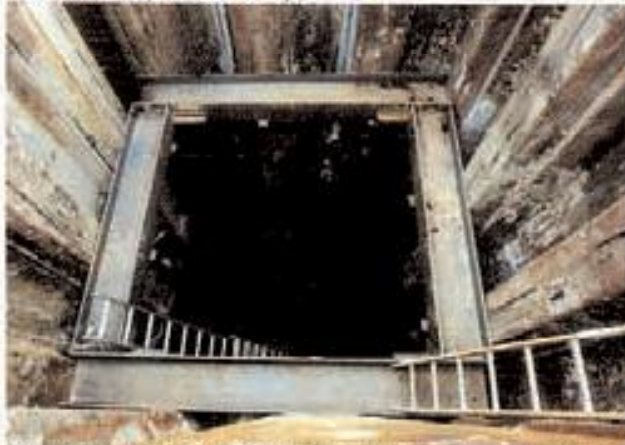
Bild 5: Freigelegter Versuchsdichtwandkasten - Spundwand mit kleinen Bohrpfehlen im Schloßbereich
