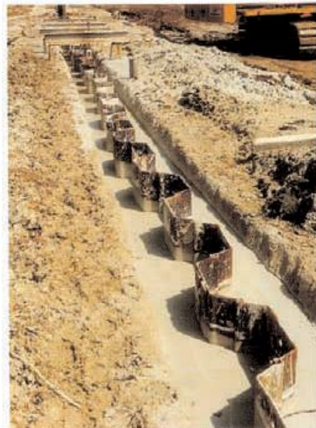
Bild 4: Schlitzwand mit eingestellten Spundbohlen
