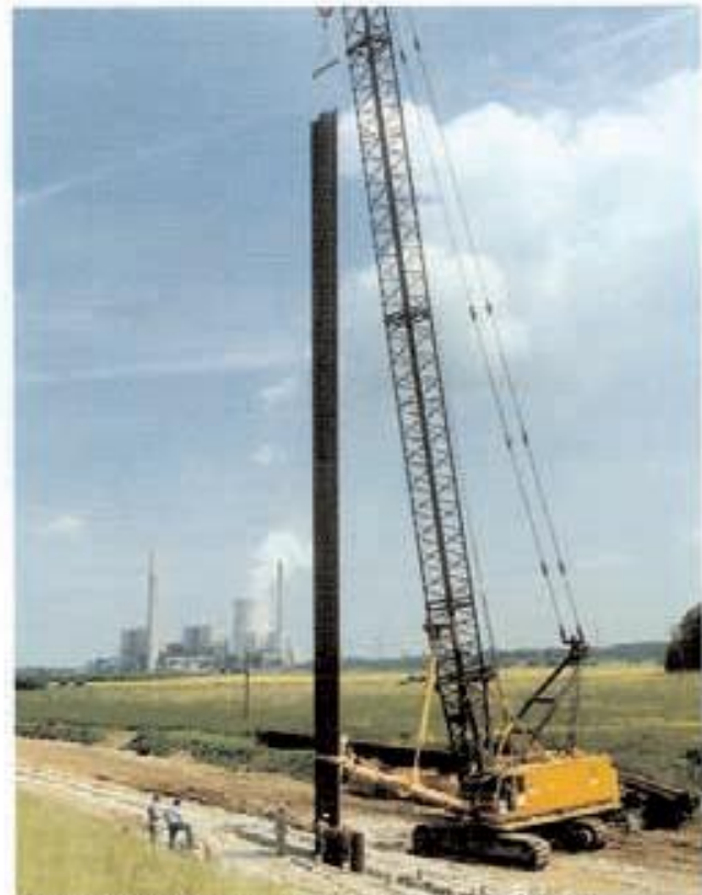
Bild 3: Einstellen von Spundbohlen in eine Schlitzwand
