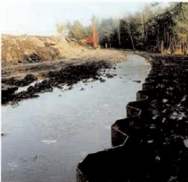
Bild 9: Dichtungspundwand Deponie Penzberg
