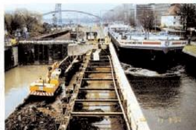
Bild 10: Mitteldamm im Bereich des alten Unterhauptes der Nordschleuse mit Bohrpfählen, Steckträgern und provisorischer Abstützung und Verankerung der nördlichen Kammerwand der Südschleuse
