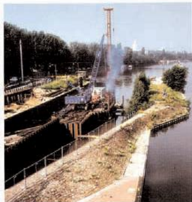
Bild 12: Rammarbeiten im Bereich der Baugrubenumachließung des neuen Unterhauptes der Nordschleuse
