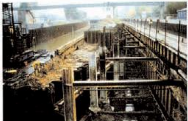
Bild 11: Mitteldamm im Bereich der Baugrube des neuen Unterhauptes der Nordschleuse
