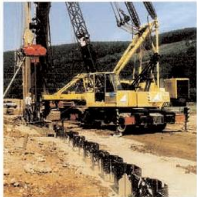
Bild 14: Kombinationsdichtwand Deponie Wildshausen
