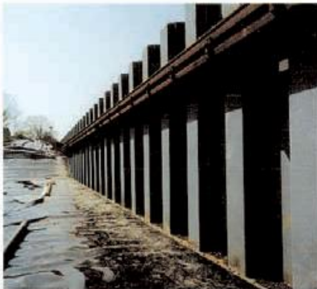
Bild 15: Dichtungsspundwand Gewerbe- und Landschaftspark Henrichshütte
