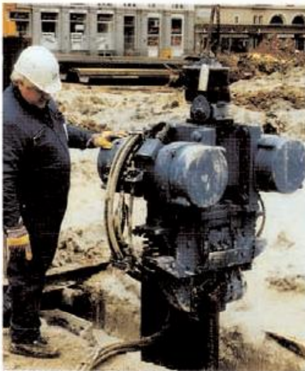
Bild 4: Einbau einer Paßbohle mit Rüttler
