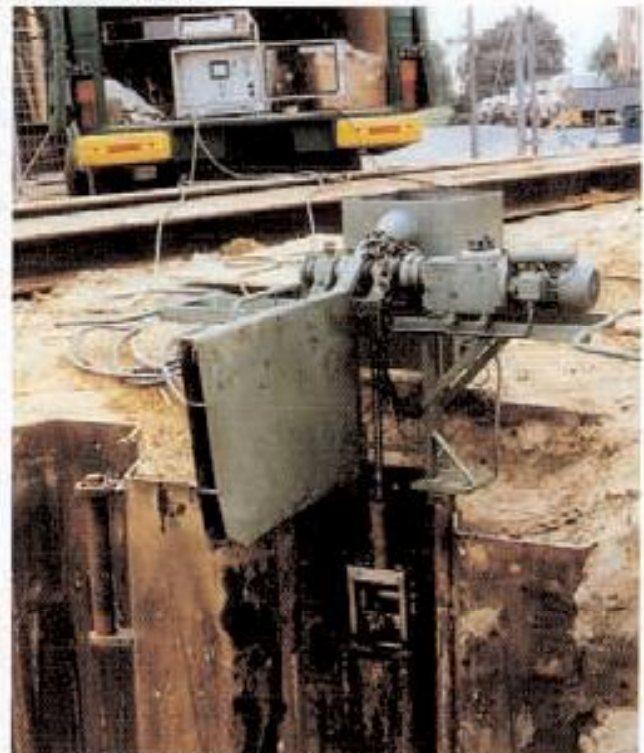
Bild 7: Baustelleneinsatz des Prüfmolches
