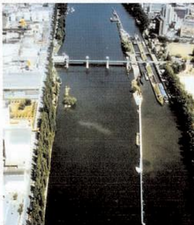
Bild 9: Staustufe Offenbach: Blick von Westen. Links: Ausbau der Nordschleuse. Rechts: Schiffahrtsbetrieb in der Südschleuse
