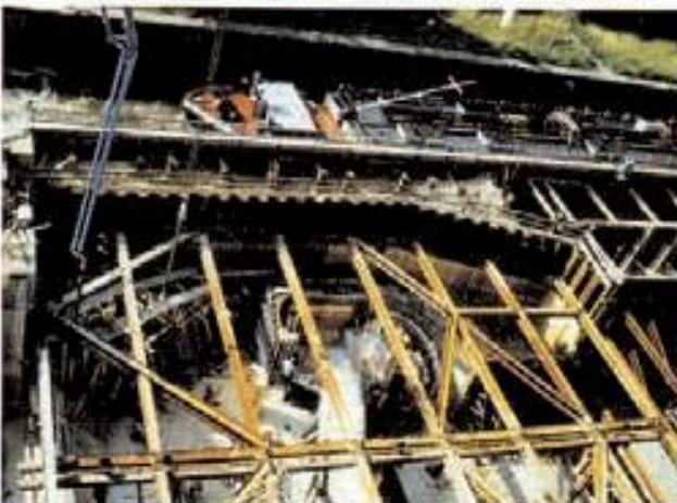
Bild 14: Blick in die Baugrube des neuen Oberhauptes der Nordschleuse, Schalung der Torumläufe
