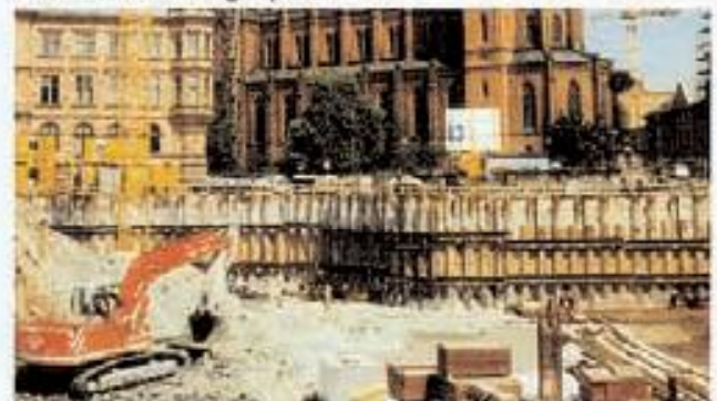
Bild 1: Verbauwand im Bereich zum Marktplatz
