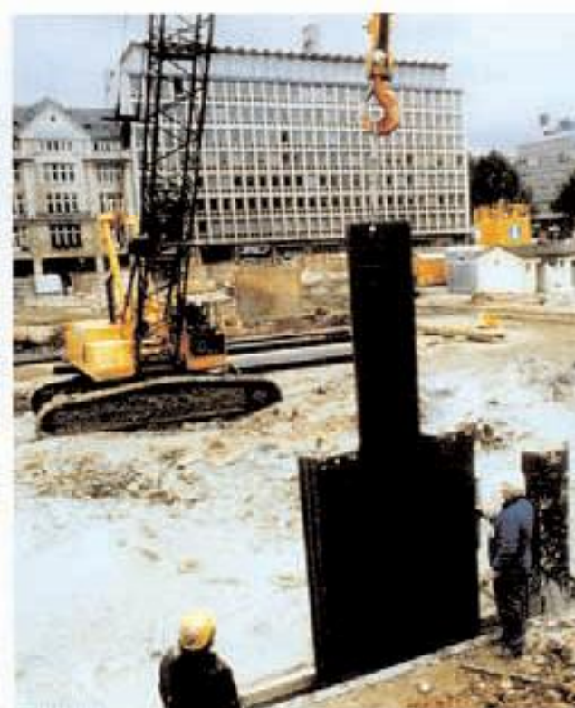
Bild 3: Einbau der Dreifachbohlen
