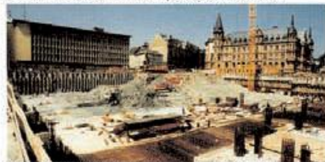
Bild 2: Baugrube mit teilweise fertiggestellter Bodenplatte
