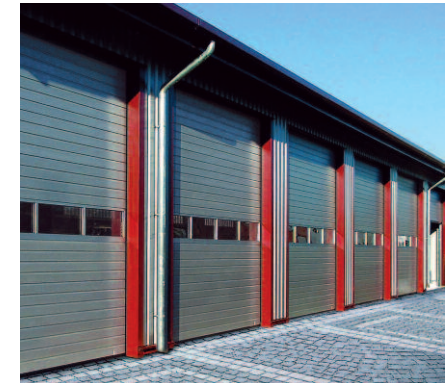
Sektionaltore aus organisch bandbeschichteten Flacherzeugnissen (oben) sowie Dacheindeckung und Abschlusselemente eines landwirtschaftlichen Gebäudes (oben links)
