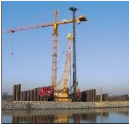
Bild 7: Spundwandarbeiten auf dem Damm
