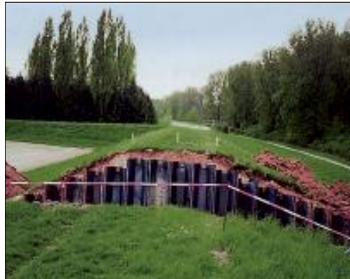
Bild 6: Spundwand am Deichkopf zur Sicherung vor Erosionen
