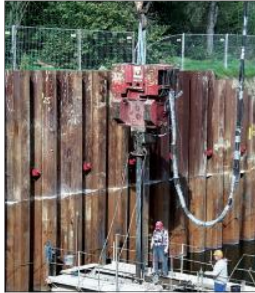
Bild 11: RI-Pfahlherstellung
