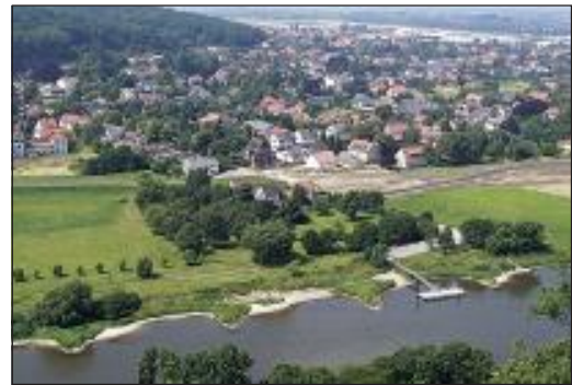
Bild 24: Aufnahme vom „Weserauentunnel“ (Stand: 07/2001)
