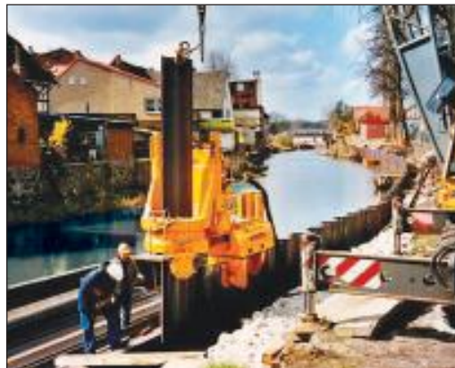
Bild 6: Silent Piler beim Kanalausbau und bei der Sanierung von Ufermauern
