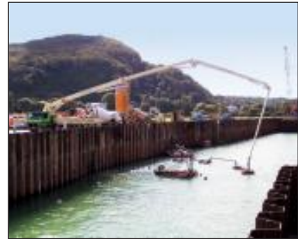
Bild 13: Herstellung der Unterwasserbetonsohle
