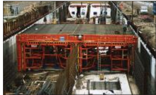
Bild 19: Schalwagen mit Deckenbewehrung
