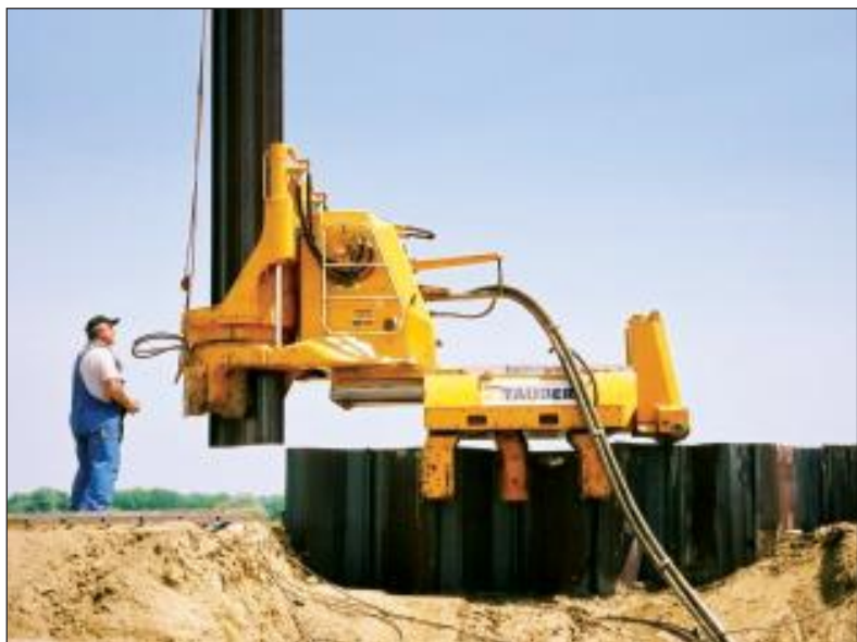
Bild 7: Sicheres und schnelles Einfädeln der Spundbohlen bei selbstschreitenden Pressen
