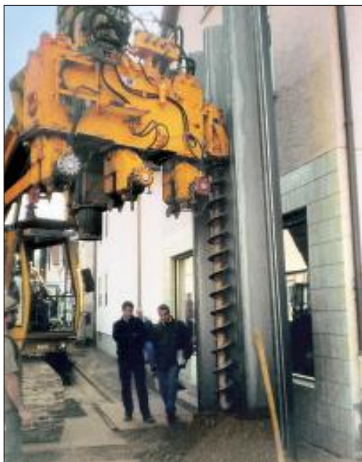
Bild 10: Auflockerungsbohrungen mit Endlosschnecke über seitliches Bohrgetriebe beim ABI Hydro-Press-Verfahren
