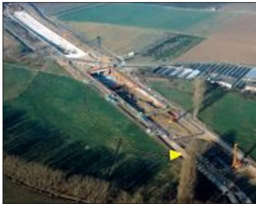
Bild 4: Kontinuierlicher Arbeitsablauf der Gewerke
