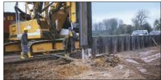
Bild 7: Niederdruckspülverfahren als Einbringhilfe
