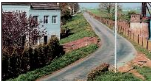
Bild 4: Einsatz von Spundwänden bei beengten Verhältnissen durch dichte Bebauung unmittelbar hinter dem Deich.
