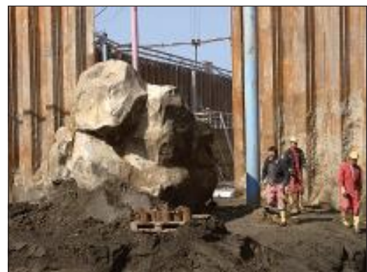
Bild 10: Große Blockeinlagerung in der Spundwandachse
