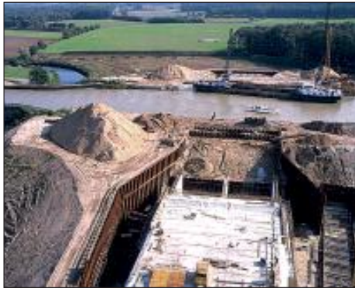
Bild 10: Baustelle im Oktober 2001
