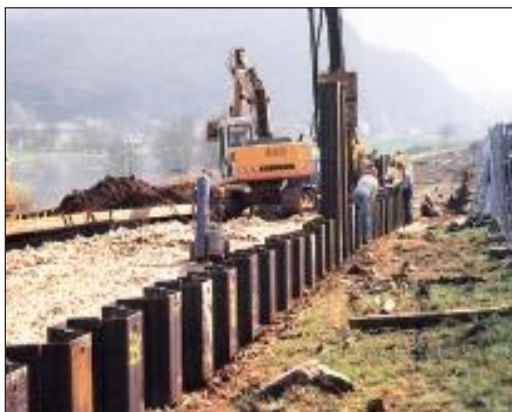
Bild 5: Spundwandherstellung
