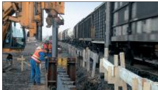
Bild 7: Einbringung der Spundwände
