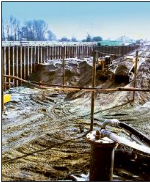
Bild 5: Wasserhaltung mit Schwerkraftpumpen im Baustock
