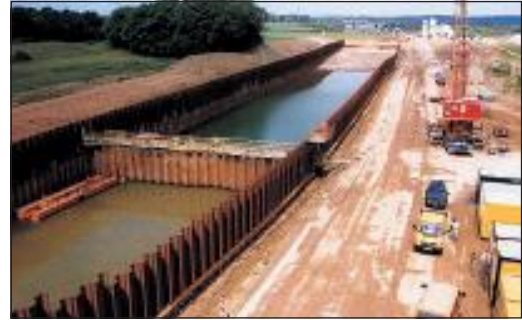
Bild 9: Spundwände der Baugruben RN 01 und RN 02 mit Querschott
