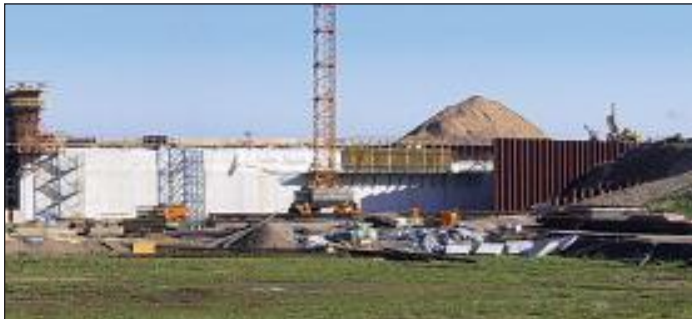
Bild 11: Bau des Mittelteils im offenen Baudock
