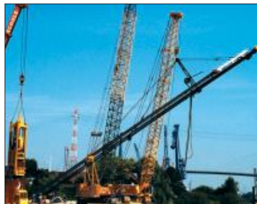
Bild 9: Schrägpfahlrammung
