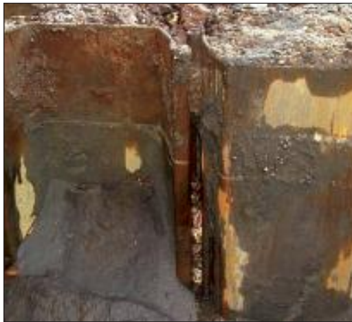
Bild 9: Schlosssprung im Querschott
