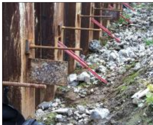
Bild 22: Ausbau der Gurtung und Durchtrennung der Temporäranker
