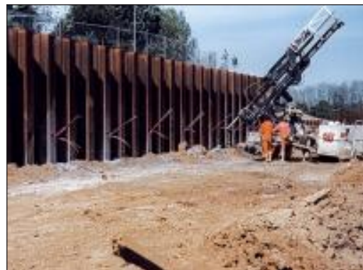
Bild 7: Ankerherstellung
