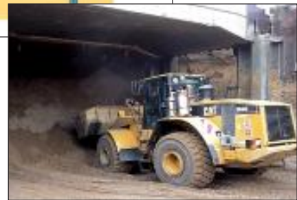
Bild 15: Erdaushub unter dem Deckel
