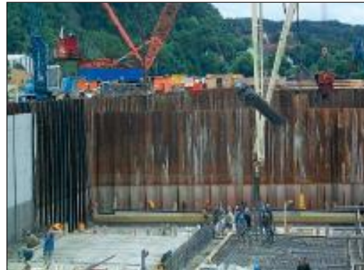
Bild 17: Betonage der Tunnelsohle
