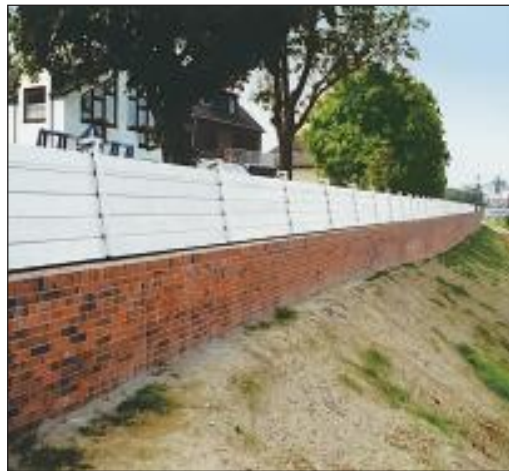
Bild 9: Mobile Wand, aufgesetzt auf Spundwand
