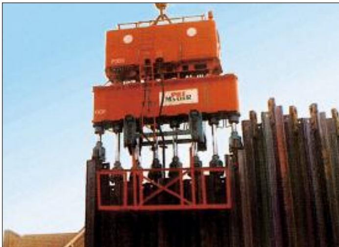
Bild 1: Erste freireitende Spundwand- presse Typ Pilemaster aus England
