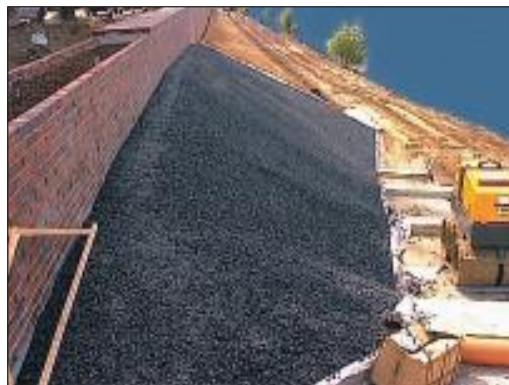
Bild 7: Böschungsaus- bildung mit Fixtone auf filterstabilem Geotextil
