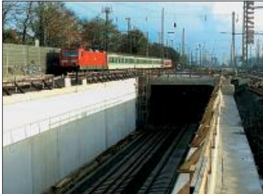
Bild 1: Baustelle Tunnel Troisdorf
