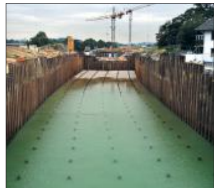
Bild 14: Unterwasserbetonsohle und RI-Pfahlraster in Baugrube BA 22
