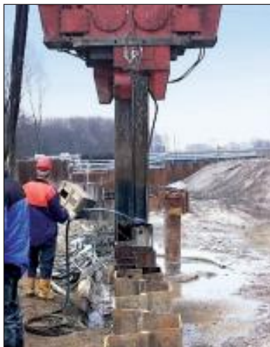
Bild 6: Einbringen der Spund- wände
