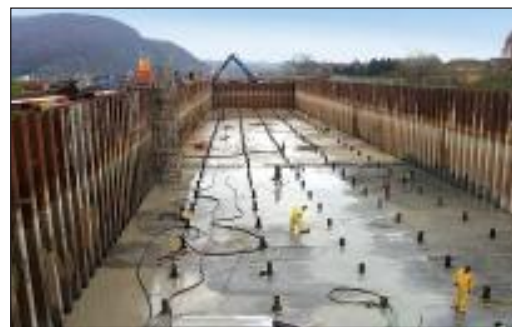
Bild 15: Reinigung der Baugrube BA 05 nach dem Lenzen
