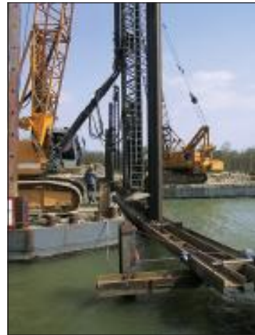
Bild 12: Spundwandaarbeiten im Kanal
