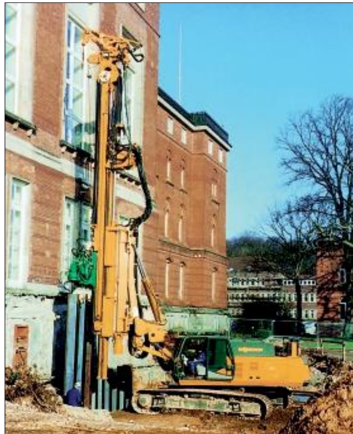
Bild 13: Hydro-Press-System beim Einbringen von Leichtprofilen dicht am Gebäude
