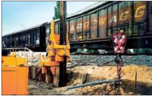
Bild 14: Erschütterungsfreies Einpressen bei Böschungssicherung entlang einer Bahntrasse
