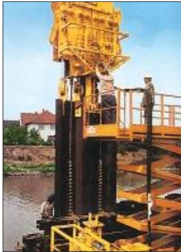
Bild 9: Integriertes Bohren beim Bohrpressverfahren System KLAMMT
