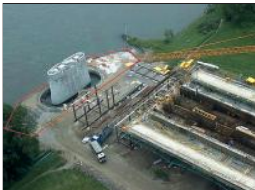
Bild 15: Fundamente für Strompfeiler
