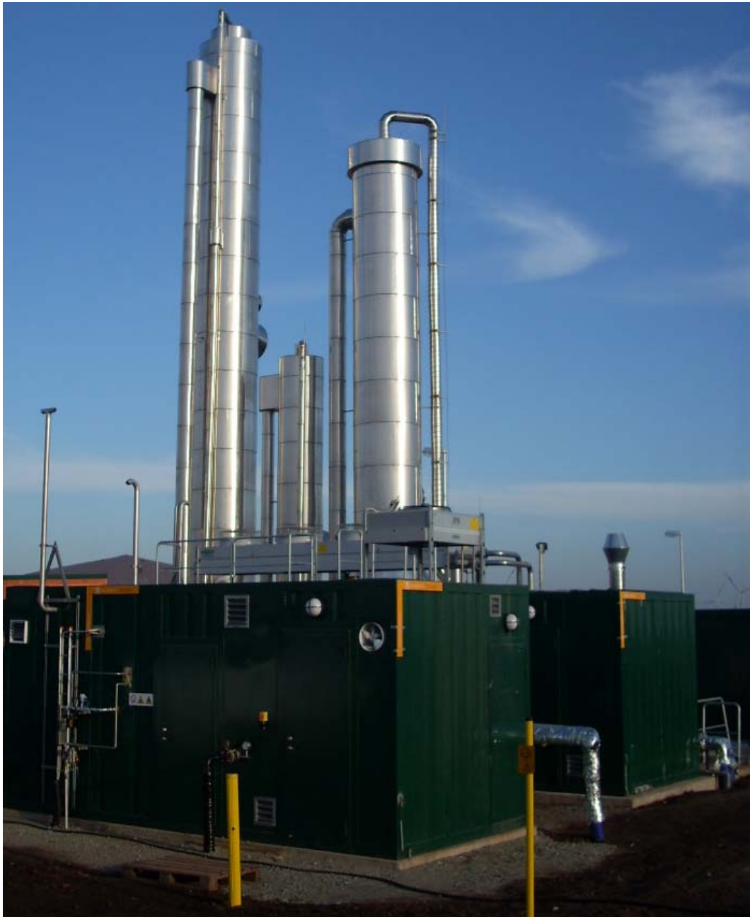
Abbildung 4-3: Druckwasserwäsche mit einer Kapazität von 1.250 Nm 3 /h Rohgas der Fa. Malmberg in Könnern, Sachsen-Anhalt, grüner Container im Vordergrund GDRM-Station (Foto Malmberg)
