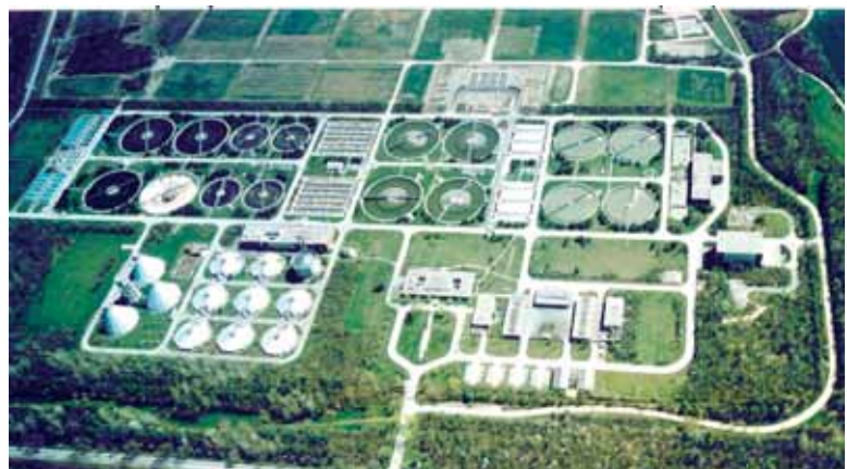
Abb. 5 Luftaufnahme der Kläranlage München II, Gut Marienhof (Foto: Photogrammertrie GmbH, München; zur Verfügung gestellt von SEW München)
