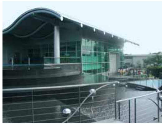
Abb. 8 Anlage zur Gewinnung von hochreinem Trinkwasser aus dem kommunalen Abwasser der Stadt Singapore: Schulklassen werden durch die Anlage geführt, um das Vertrauen der Bevölkerung in die neue Technik zu fördern
