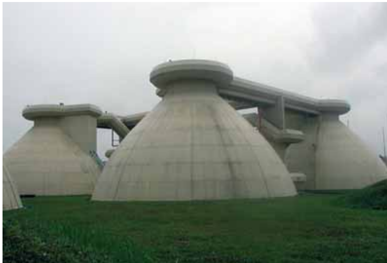
Abb. 6 Beispiel für Faulbehälter zur anaeroben Behandlung von Klärschlamm (Kläranlage Singapore)
