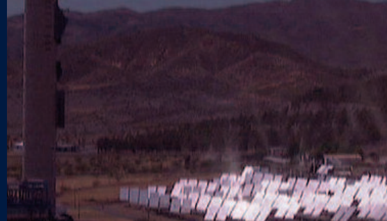
Solarturmkraftwerk des DLR im spanischen Almeria
