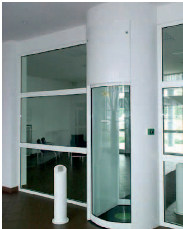
Personenschleuse, in die die neuen Sensoren integriert werden können
