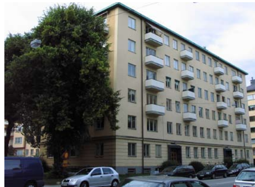
Kv. Demonstrationen, Värtavägen 15 och 17 sett från Värtavägen. De båda portarna har utformats med sidostycken i svart granit rikt illustrerade med bilder huggna i relief med 1930-talsmotiv.
