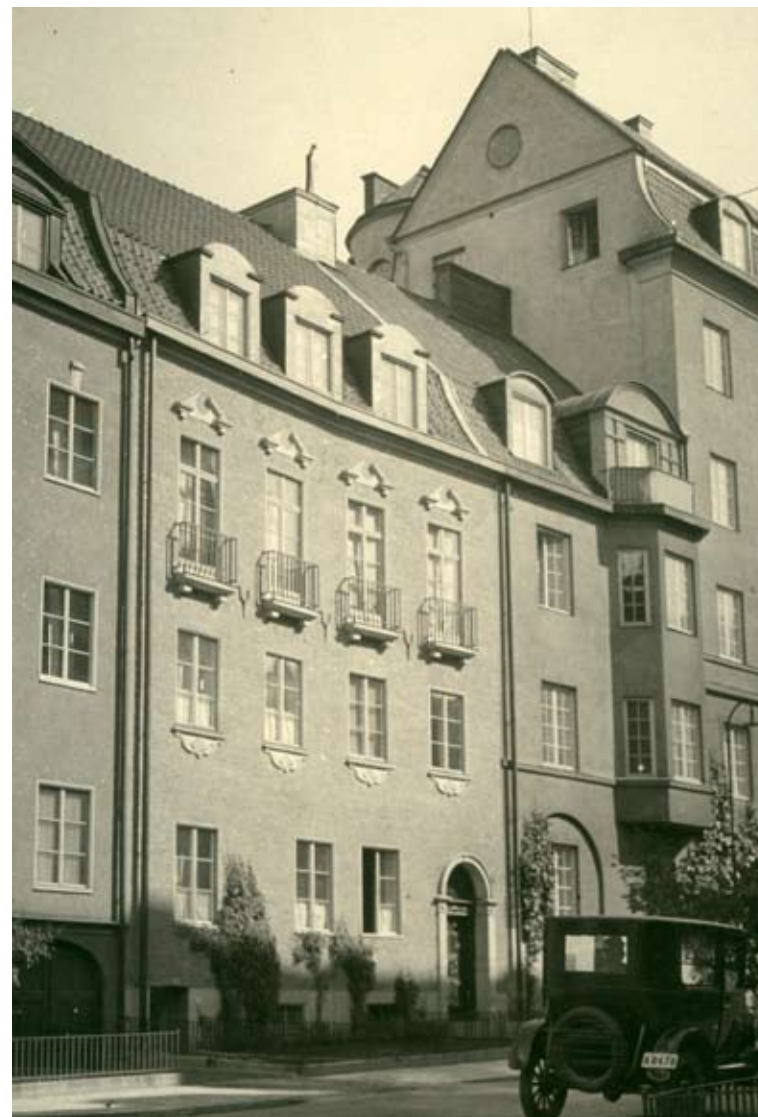
Kv. Furiren, bostadshus, Tysta gatan 4, 1922. Paradvåningen under takvåningen dominerar fasaden genom fyra höga fönsterdörrar med smidesräcken. Entréplanets tre fönster och den förhöjda entréporten bryter symmetrin genom att porten sitter excentriskt och att två av de tre fönstren förts närmare samman.
