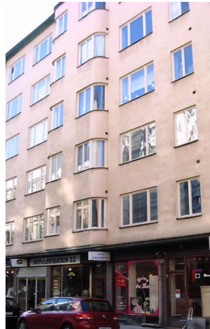
Kv. Sjöhästen 27, Artillerigatan 33, 1936, Bostadshus i sex våningar. Burspråk med rundade glasade hörn.
