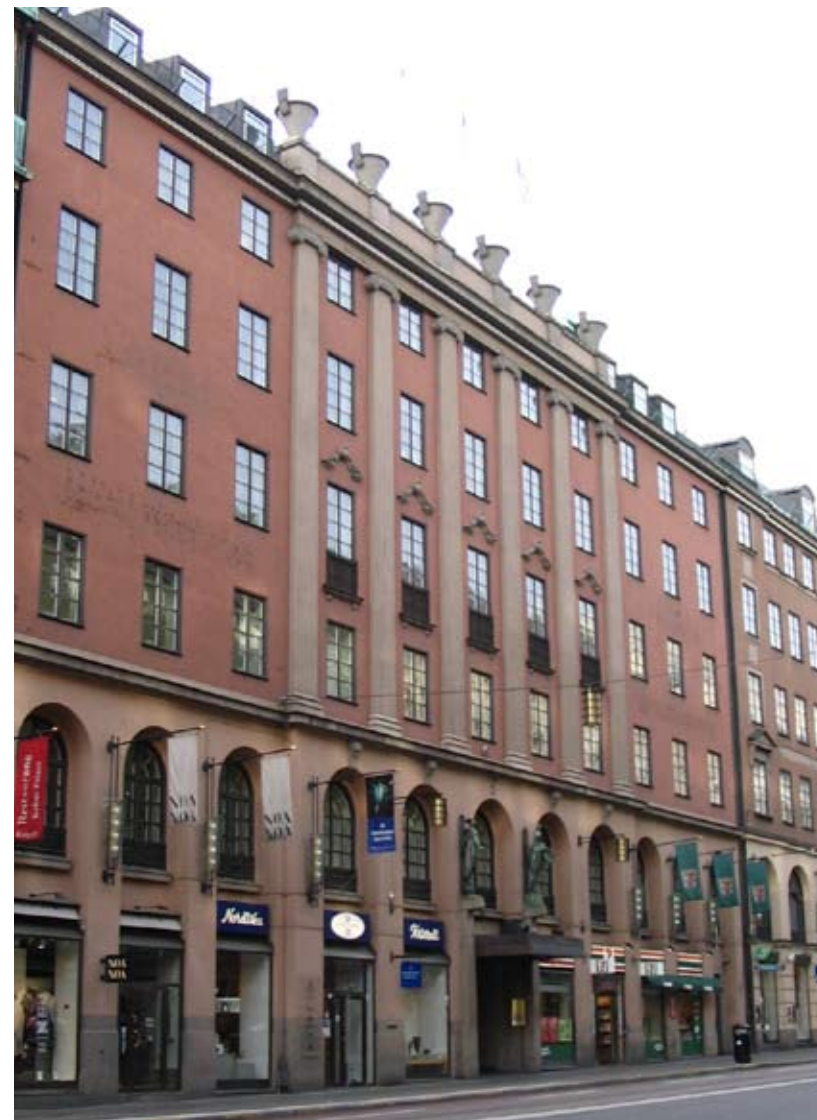
Kv. Bocken, kontorshus på Kungsgatan 9–13, 1915. Fasad i nyklassistisk utformning med bottenvåning i granit och övriga våningar i putsat tegel. Albin Stark var mån om att integrera konstnärlig utsmyckning i arkitekturen. Entrépartiet har en markerade portal med flankerande bronsskulpturer och sex stora »urnor« på taket.
