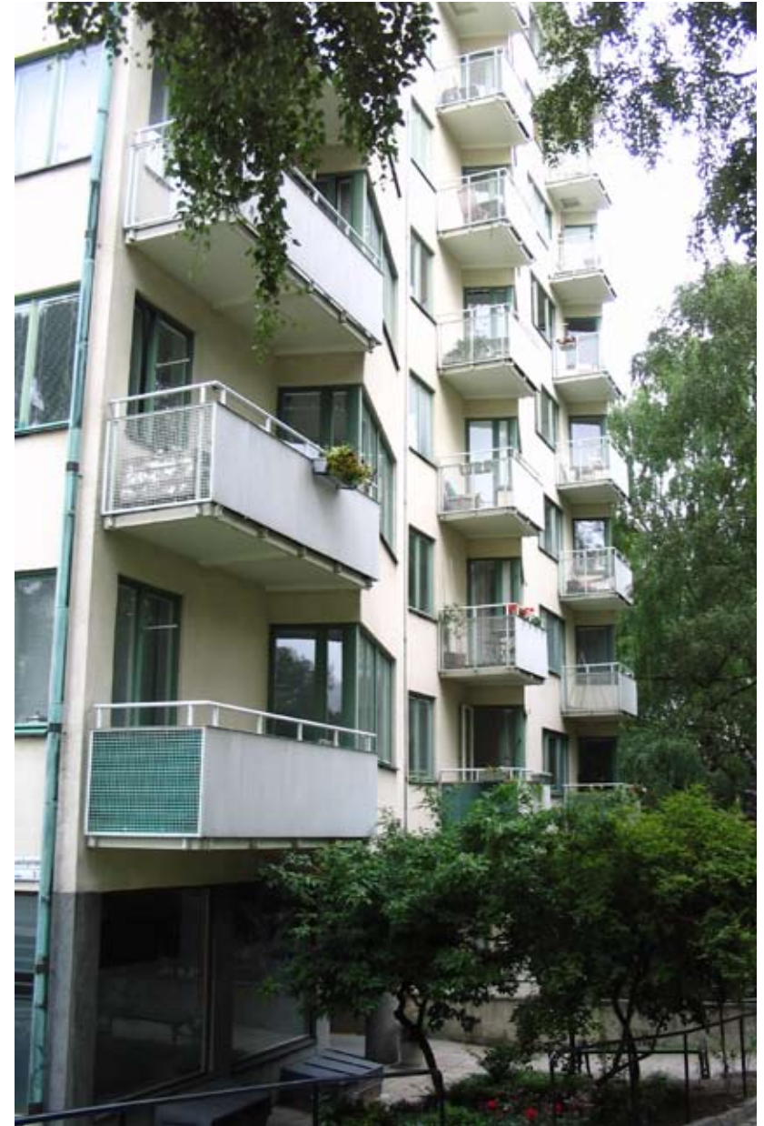
YK-huset, Furusundsgatan 11, Fasad sedd från entrésidan.
