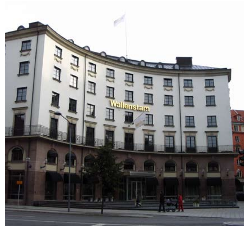
»Shellhuset« sett från korsningen Birger Jarlsgatan och Rådmanngatan. Detaljer som smidesracket utefter den långsgående balkongen och utsmyckningar som Shellsnäckan finns kvar i ursprungligt skick. Byggnaden restaurerades för Wallenstam 2003.
