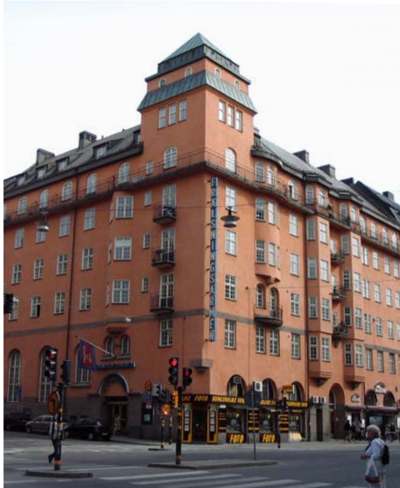
Kv. Hantverkaren – Frälsningsarméns hus på S:t Eriksgatan 30 – sedd från korsningen S:t Eriksgatan och S:t Göransgatan. Notera den långa balkongen som sträcker sig längs hela fasaden runt hörn – ett motiv som återkommer i Albin Starks verk.
