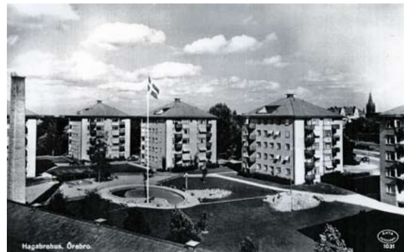
Kv. Förmannen och Kv. Hyvlaren i Örebro, 1945–47. Flerbostadsområde med fristående femvåningshus och ett lägre envåningshus kring en gemensam gård.
