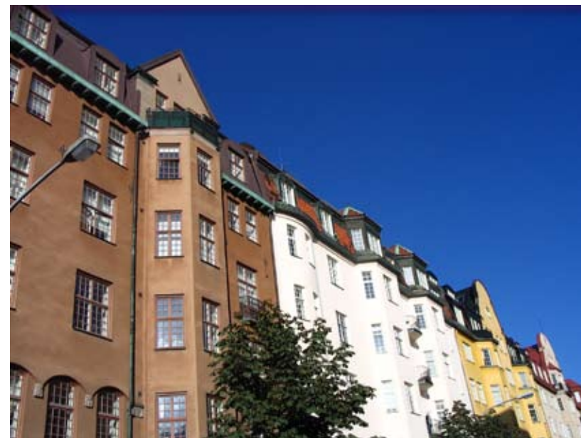
Kv. Djursborg 2, 3 och 4, Erik Dahlbergs Allé 5, 7 och 9, 1912–1916. De tre sexvåningshusen har alla en egen fasadutformning rikt artikulerad i nationalromantisk stil med burspråk genom flera våningar, balkonger, markerad taklist och takkupor, vilket ger en varierad taklist, och omsorgsfullt utarbetade entrépartier.
