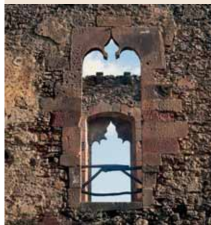
Laconi – Particolare dei resti del castello.
